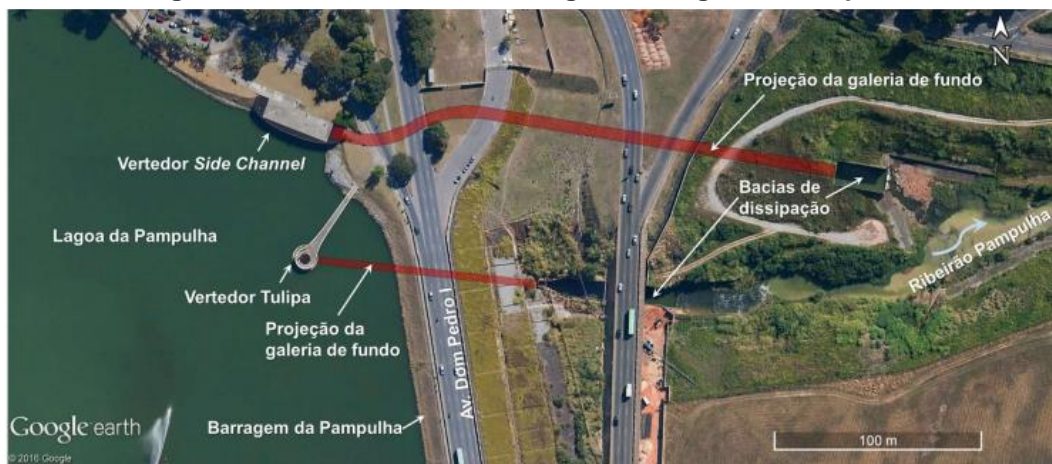
Figura 16 – Vertedouros da barragem da Lagoa da Pampulha
