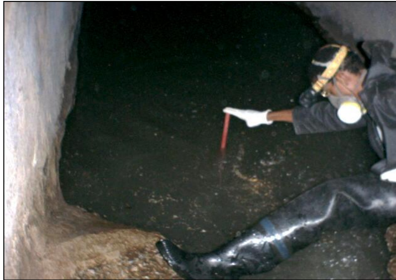
Figura 3.16- Cavitação provocou uma enorme cratera após um degrau na galeria do Córrego da Serra (BH)
