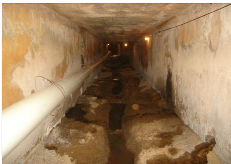
Figura A.2.5 – Aspecto da galeria logo após o ensecamento e iluminação provisória
