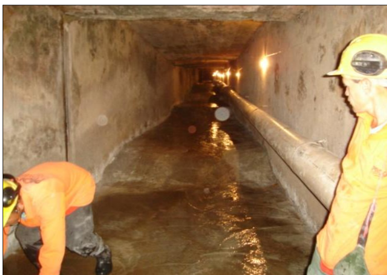
Figura A.2.10 – Visão da laje de piso depois do acabamento da superfície, observando que os degraus foram transformados em rampas suaves
