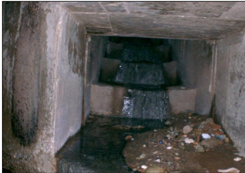
Figura 3. 14 – Galeria da Av. Mem de Sá (BH) foi construída em degraus para reduzir a velocidade do fluxo
