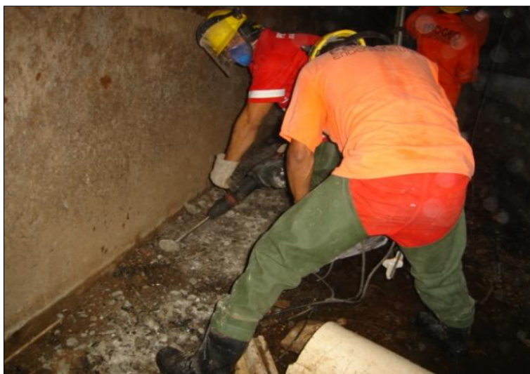
Figura A.2.7 – O piso comprometido foi demolido, ficando somente áreas íntegras
