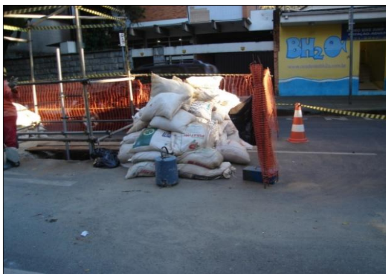
Figura A.2.3 – O acesso de pessoas e material foi realizado por aberturas na laje de teto
