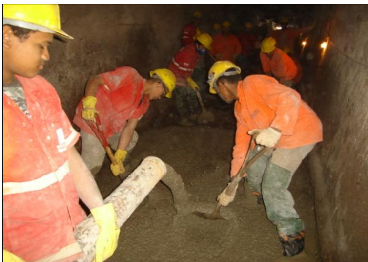
Figura A.2.9 – Reconstituição do piso com concreto bombeado
