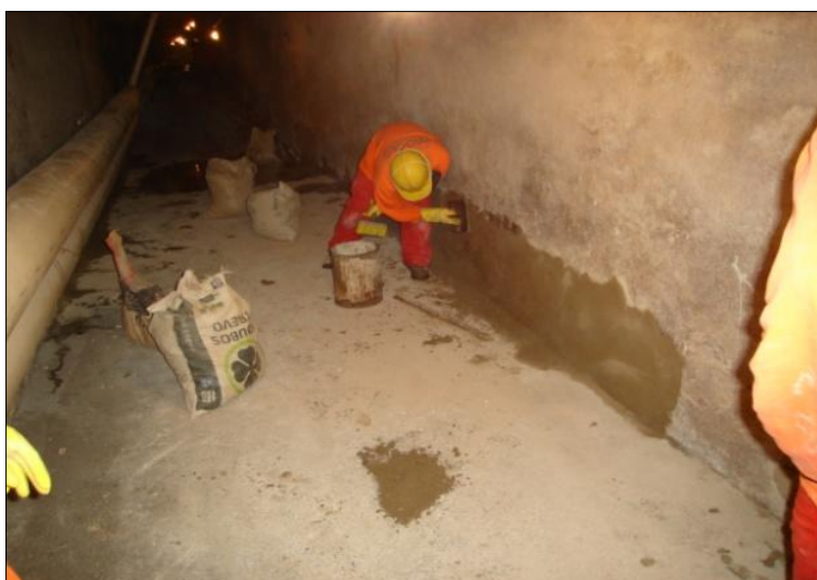
Figura A.2.11 – Reparos das armaduras expostas nas paredes com argamassa polimérica
