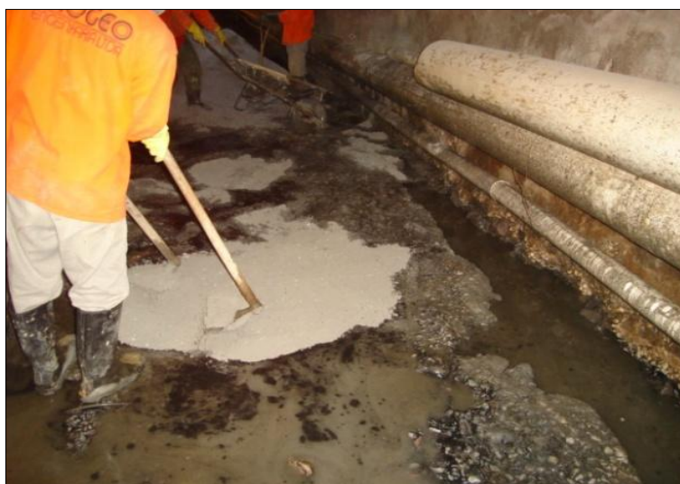
Figura A.2.6 – As cavidades maiores foram preenchidas com material britado
