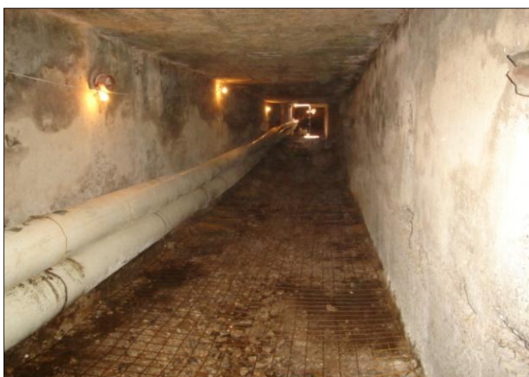
Figura A.2.8 – Instalação de uma malha de aço sobre o piso
