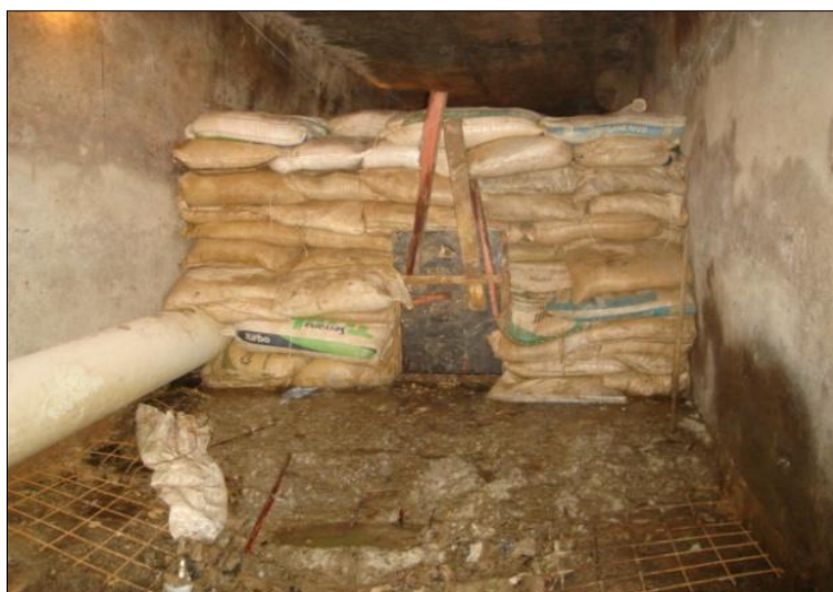
Figura A.2.4 – A barragem permitiu canalizar a água em tubos de PVC para ensecar a galeria
