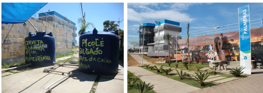
FIGURA 51 – Caixas d'água construídas pela comunidade para abastecimento das casas do morro e reservatório de água destinado exclusivamente ao abastecimento da sede da UPP Fazendinha
