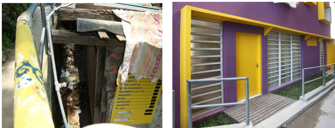
FIGURA 44 – Antes e depois da fachada da casa reformada no Morro Santa Marta pela série “Lar Doce Lar”, da Rede Globo
