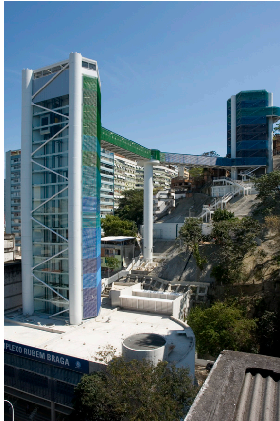
FIGURA 03 – Elevador do Cantagalo, no Rio de Janeiro.
