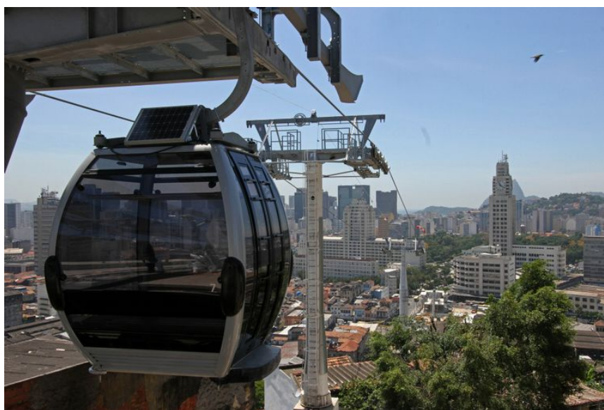
FIGURA 02 – Teleférico do Morro da Providência, Rio de Janeiro.
