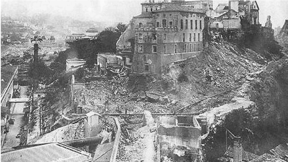
FIGURA 27 – Obras de demolição no Morro do Castelo, no centro do Rio de Janeiro, em 1921
