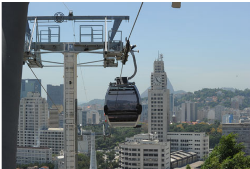
FIGURA 24 – Teleférico da Providência, no Rio de Janeiro
