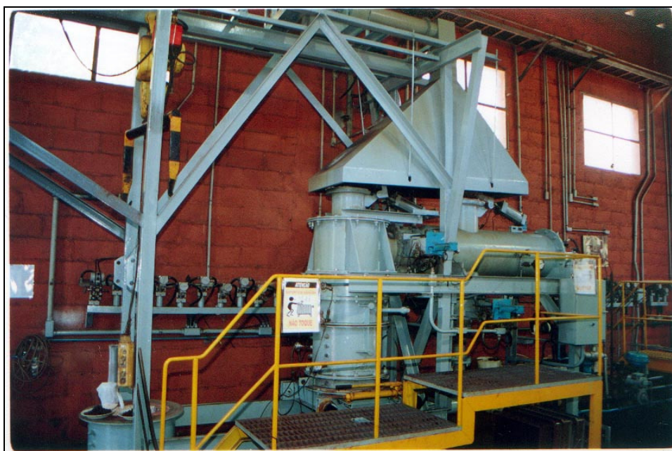
Figura 4.12 – Instalações do forno de queima ( pot grate ) – Planta piloto Samarco.
