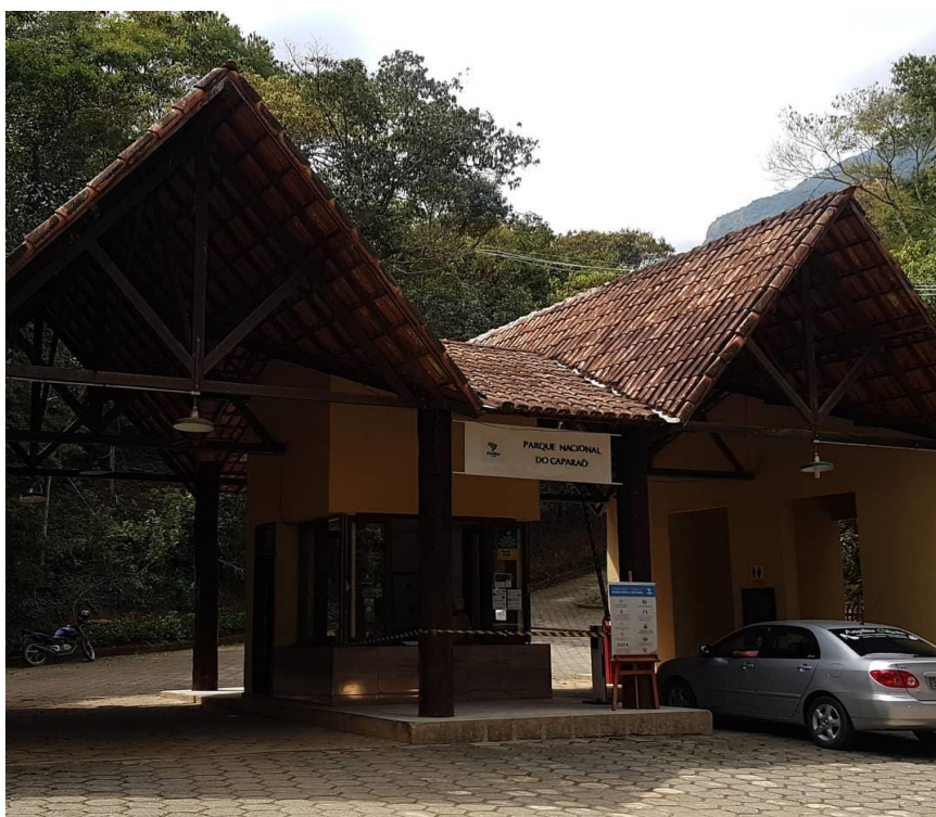
Figura 2- Portaria em Alto Caparaó - Parque Nacional do Caparaó
