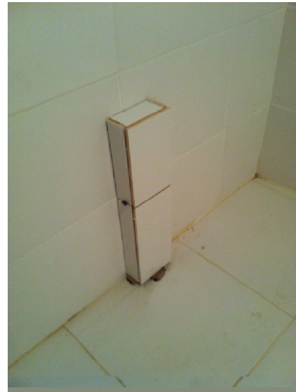
IMAGENS 13 e 14. Exemplos da mesma solução para execução de ponto hidráulico para instalação de torneiras em cômodos técnicos.
