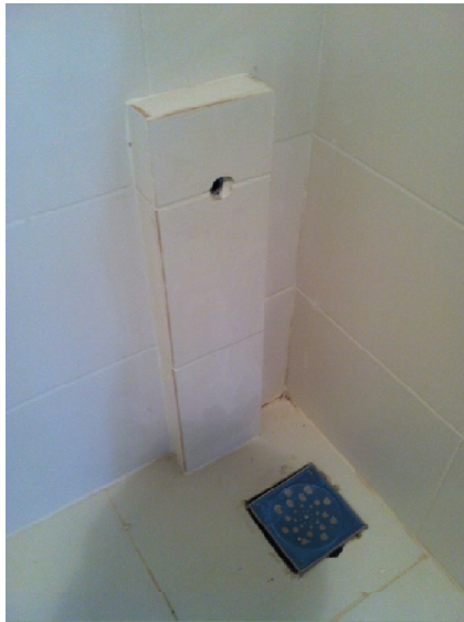
IMAGENS 13 e 14. Exemplos da mesma solução para execução de ponto hidráulico para instalação de torneiras em cômodos técnicos.
