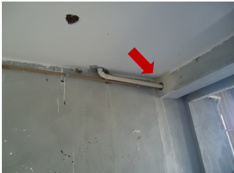
IMAGEM 19. Apartamento. Viga perfurada para passagem de tubulação hidráulica.
