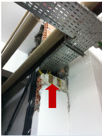
IMAGEM 23a e 23b. Garagem 1. As imagens mostram interferência entre um shaft * de instalações elétricas, executado em alvenaria, tubulações hidráulicas e eletrocalha.
