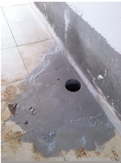
IMAGEM 22a. Pilotis. Furo realizado em laje com o piso em revestimento cerâmico já realizado para inserção de ralo.
