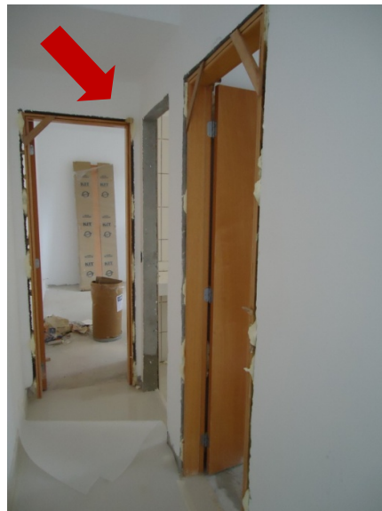
IMAGEM 10. A porta indicada não foi instalada devido à dimensão do vão incorreta. Isso gerou atraso na conclusão deste serviço neste apartamento e comprometeu a sequência de atividades futuras.
