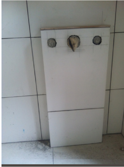
IMAGENS 11 e 12. Ilustram as soluções para proteção das tubulações hidráulicas dos lavatórios e como foi realizado o revestimento cerâmico destes elementos.
