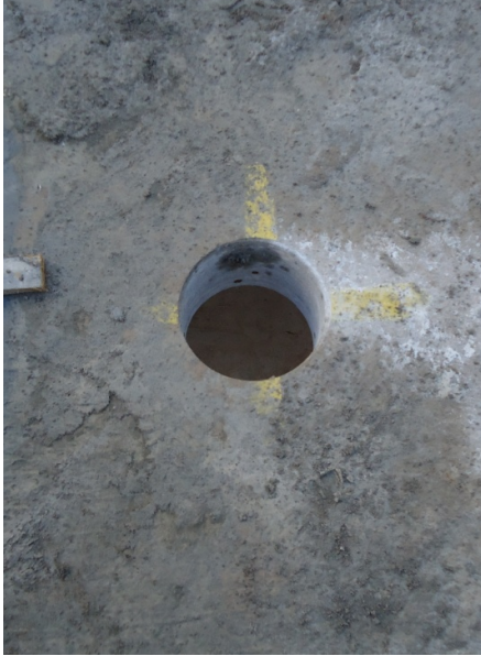
IMAGEM 20. Garagem 1. Exemplo de furo realizado e laje para passagem de tubulação.
