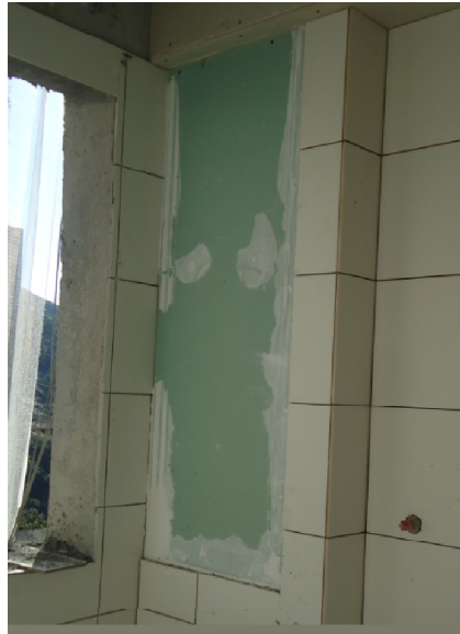
IMAGEM 17. Shaft executado na área de serviço para instalação das prumadas hidráulicas e alimentação do tanque. Foi protegido com placas de gesso resistentes à umidade e revestido com cerâmica.
