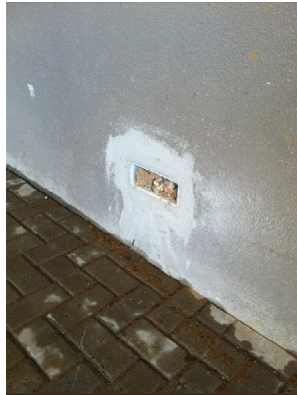
IMAGEM 7. Pilotis. Alvenaria recuperada após recorte para embutir eletroduto. Neste caso, a pintura já havia sido realizada e, para evitar manchas, todo o “pano” precisou ser refeito.
