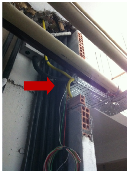
IMAGEM 23a e 23b. Garagem 1. As imagens mostram interferência entre um shaft * de instalações elétricas, executado em alvenaria, tubulações hidráulicas e eletrocalha.
