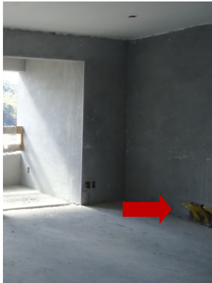
IMAGEM 6. Apartamento. Recorte na alvenaria para passagem de eletrodutos e instalação de caixinhas elétricas.
