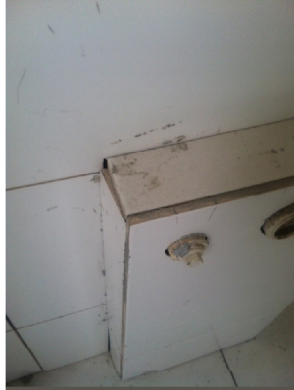
IMAGENS 11 e 12. Ilustram as soluções para proteção das tubulações hidráulicas dos lavatórios e como foi realizado o revestimento cerâmico destes elementos.
