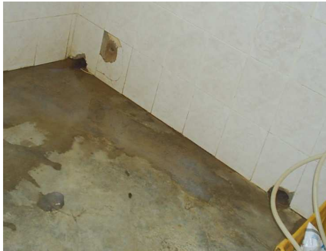
Figura 19. Ralos não sifonados e sem sistema de fechamento em indústria que beneficia o leite e o distribui para o programa governamental.
