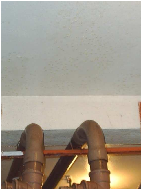
Figura 18. Forro com condensação de água em laticínio que participa de programa governamental de distribuição de leite.
