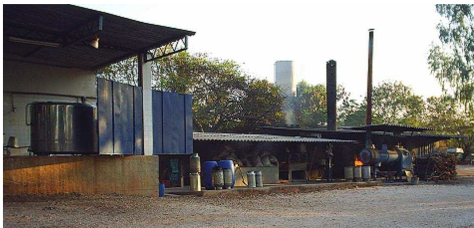
Figura 11. Laticínio localizado próximo à depósito de lenha e entulhos.
