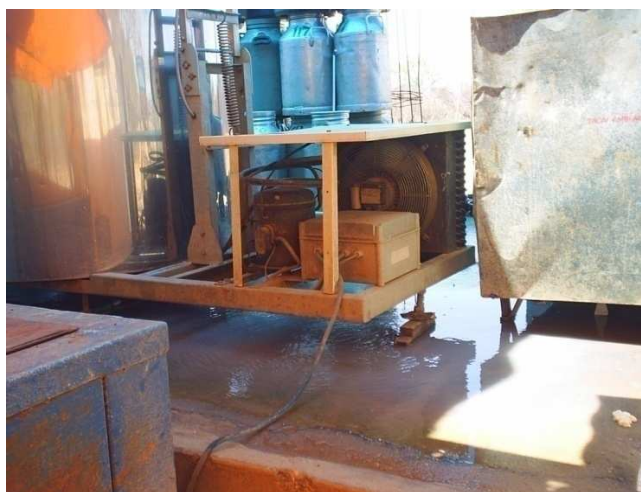
Figura 21. Plataforma de recepção/expedição alagada (água misturada com leite) observada em um laticínio que pasteuriza leite e participa de programa governamental.
