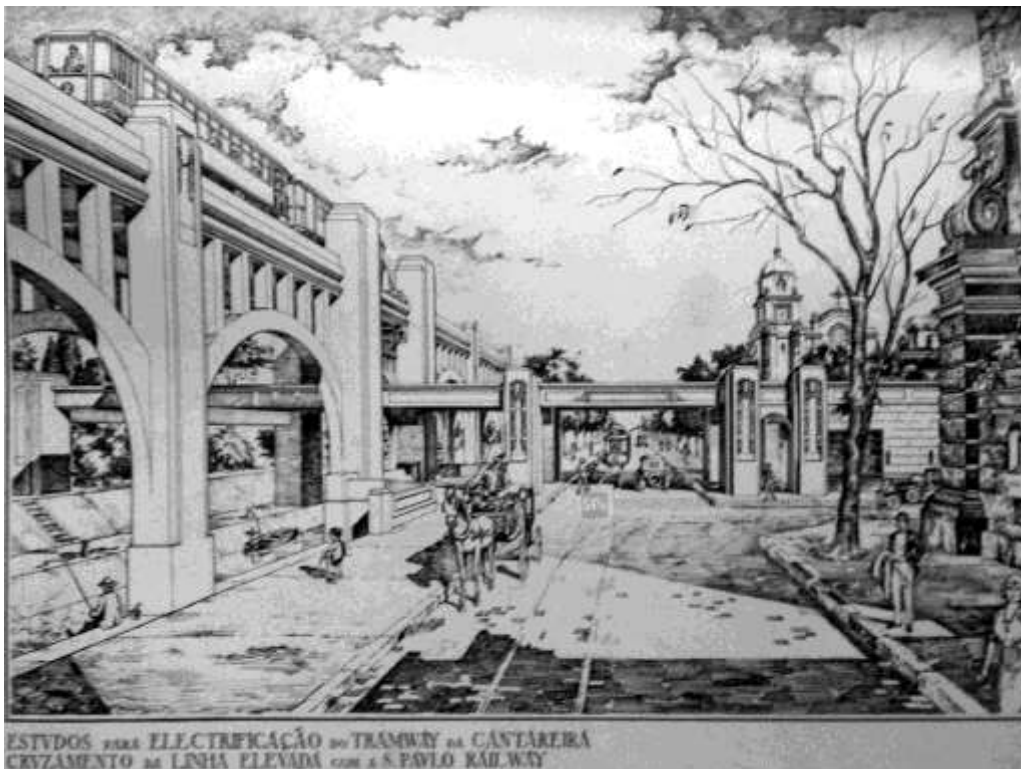
Figura 17 Estudos para a instalação da tramway da Cantareira.
