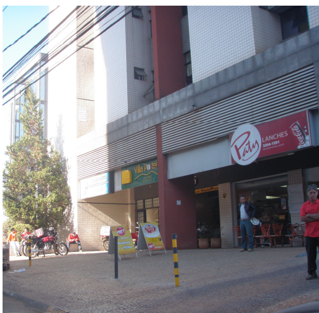
FIGURA 55 - Prédio comercial e de serviços no Vila da Serra
