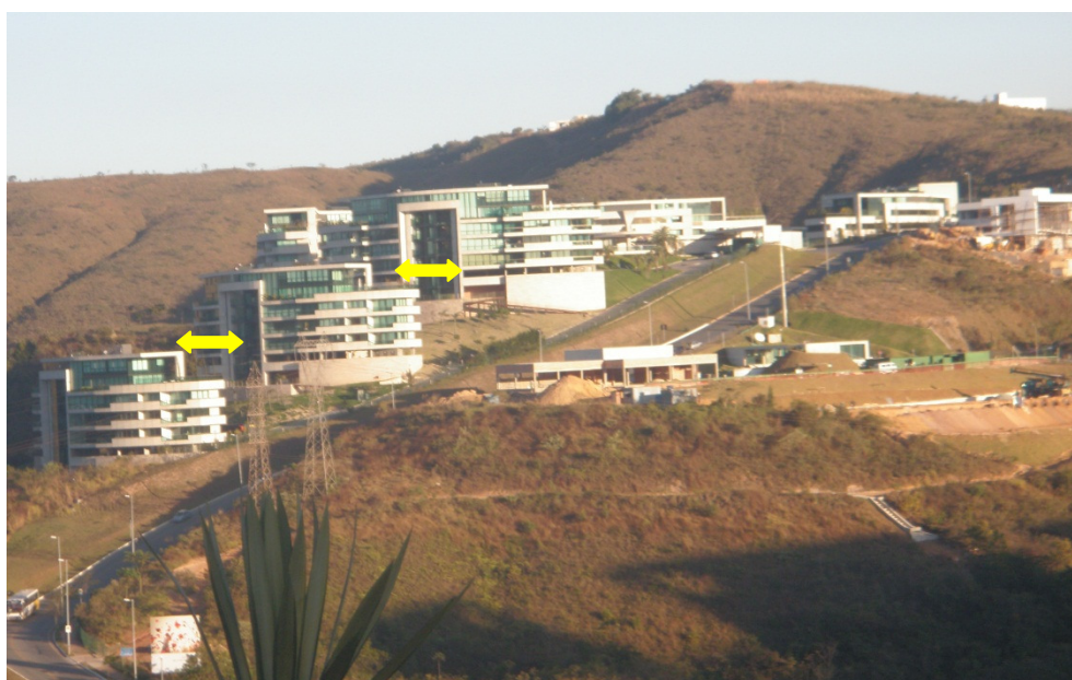
FIGURA 71 - Condomínio Vila Gardner
