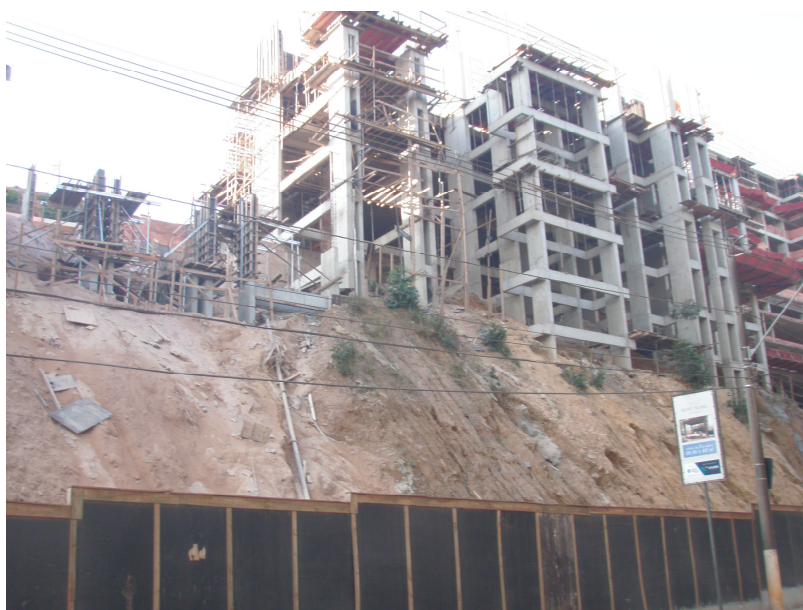
FIGURA 58 - Construção no Vila da Serra, limite com o Belvedere III
