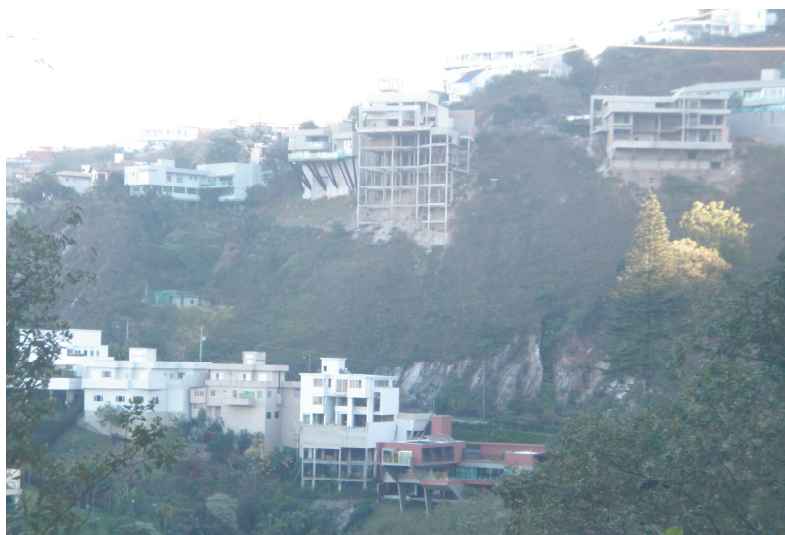
FIGURA 36 - Casa em “palafitas” e solo exposto no Vila Castela
