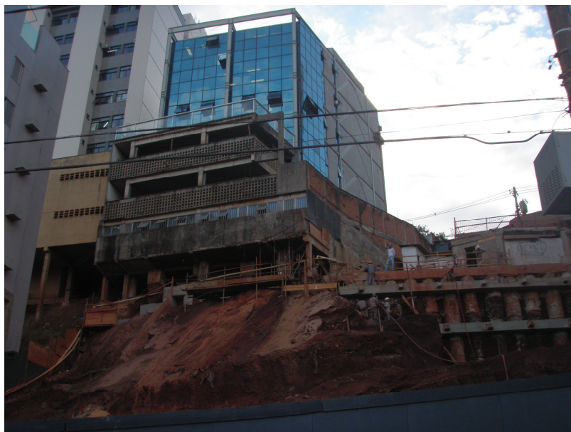
FIGURA 59 - Estrutura de prédio de serviço e comercial no Vila da Serra
