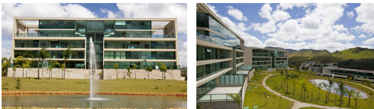
FIGURA 65 - Condomínio Vila Hartt
