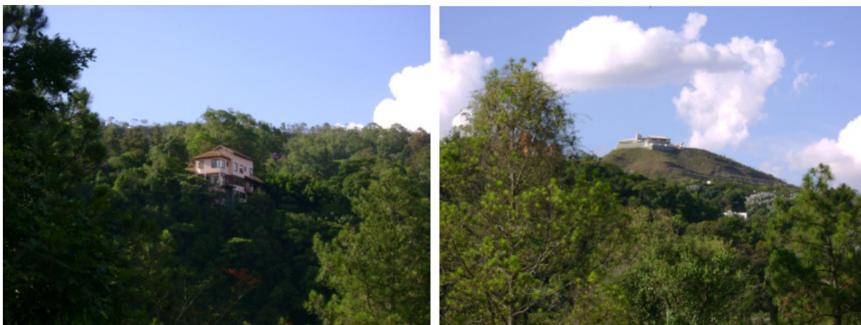
FIGURA 35 - Vista panorâmica a partir do Condomínio Bosque da Ribeira - Construções em encosta de alto declive e em topo de morro
