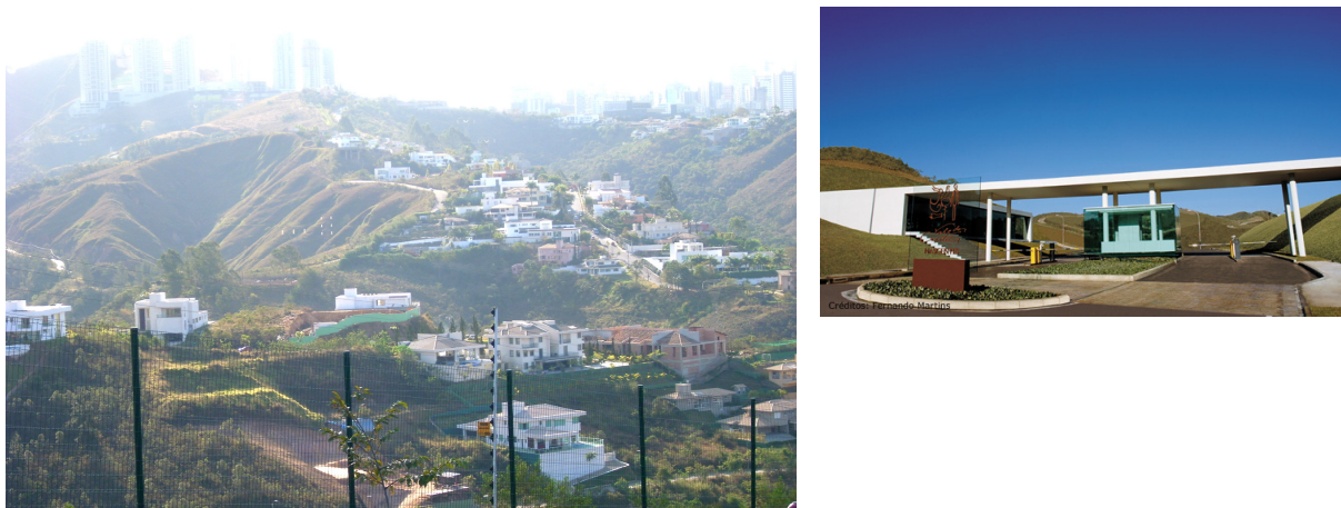
FIGURA 63 - Condomínio Nascentes – vista geral e portaria
