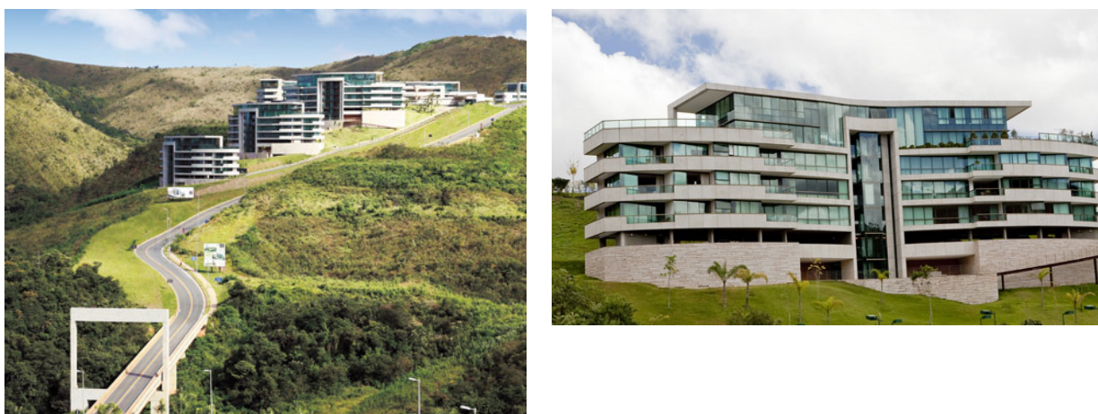
FIGURA 64 - Condomínio Vila Gardner.
