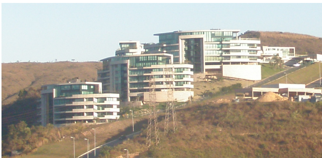
FIGURA 70 - Vista do condomínio Vila Gardner, no Vale dos Cristais
