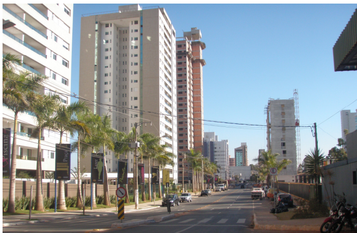
FIGURA 52 - Prédios residenciais ao longo da Alameda da Serra
