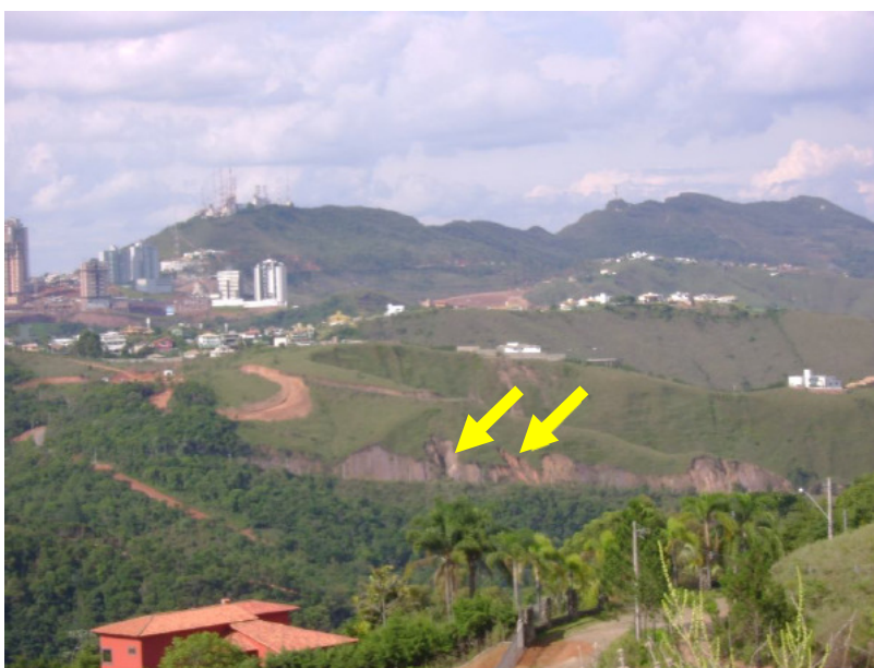
FIGURA 69 - Vista Panorâmica do Condomínio Vale dos Cristais: presença de voçorocamento causado provavelmente por cortes na estrada
