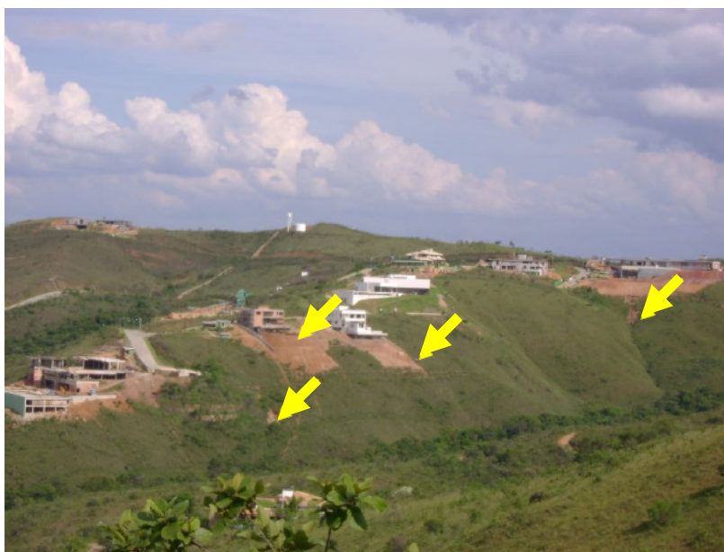
FIGURA 34 - Vista Panorâmica do Condomínio Vila do Conde: Terraplanagens e presença de um voçorocamento
