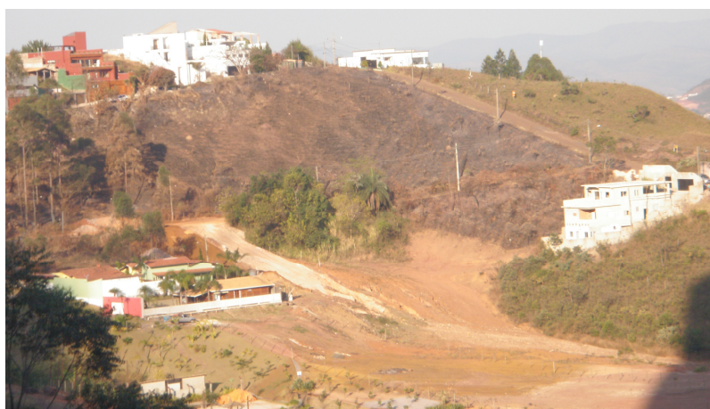
FIGURA 51 - Edificações no bairro Jardim da Torre
