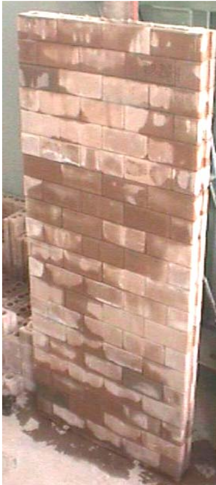
Figura A25 – Vista geral da parede P2 com 20 fiadas, depois de concluída a última injeção
