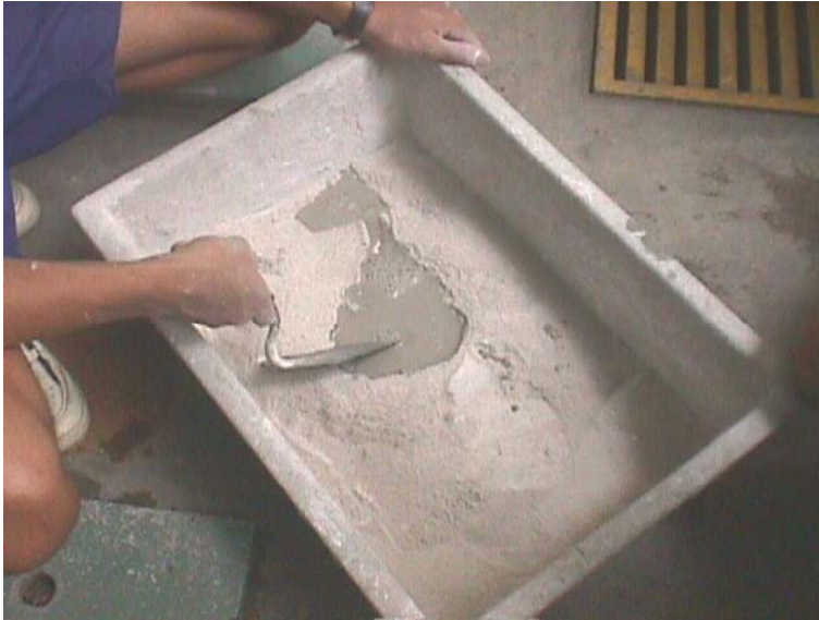
Figura 9.11 – Preparação da argamassa de injeção, cimento cal e areia lavada
