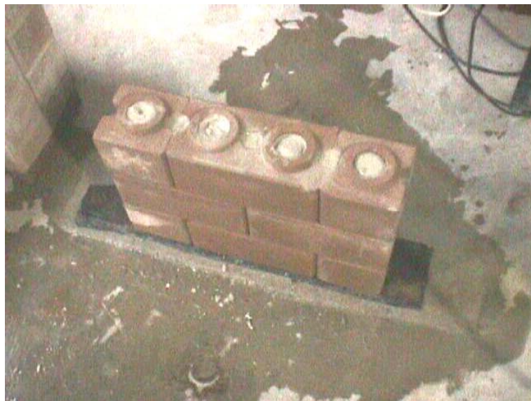
Figura 9.12 – Parede com as três primeiras fiadas já injetadas
