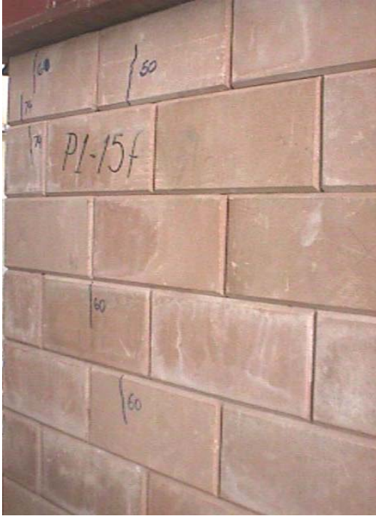
Figura A22 (à esquerda) – Fissuração na parede P1 com 15 fiadas, na face sul, após a carga máxima
