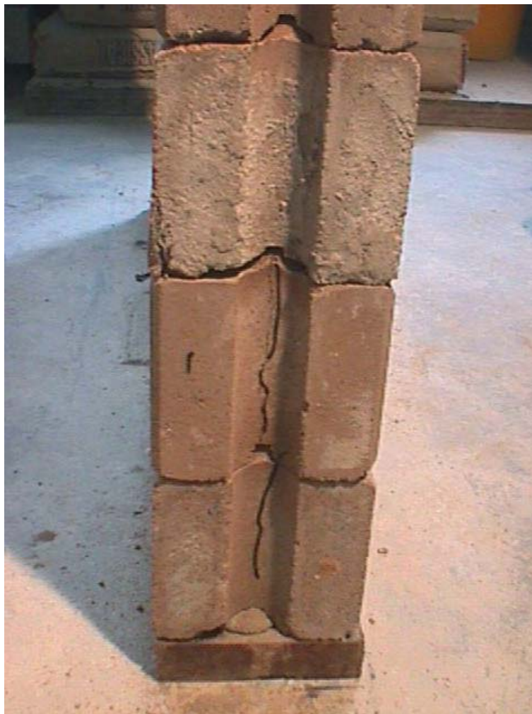
Figura 11.9 – Fissuração em P4 de [4x20] – face leste inferior
