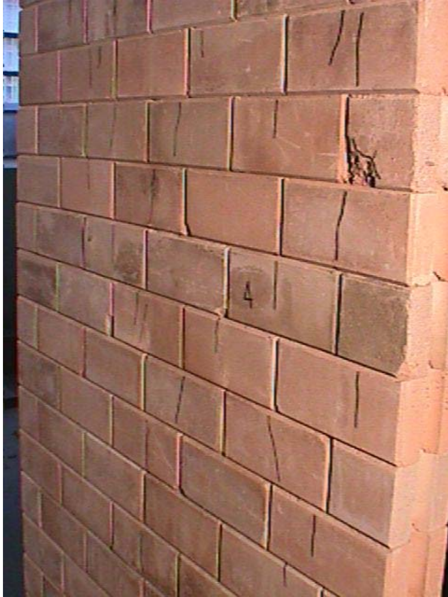
Figura 11.10 – Fissuração em P2 de [5x24] – face sul central
