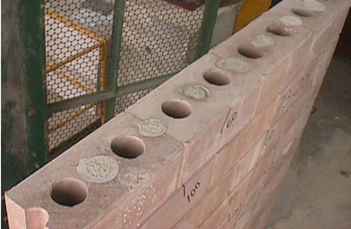
Figura A24 – Detalhe dos tijolitos da última fiada, sem o macho, injeção dos furos pequenos
