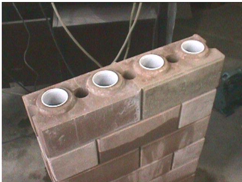
Figura 9.14 – Colocação de tampões nos furos grandes sob a penúltima fiada
