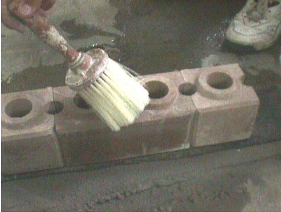
Figura 9.8 – Limpeza da parte superior da fiada, antes da colocação da seguinte
