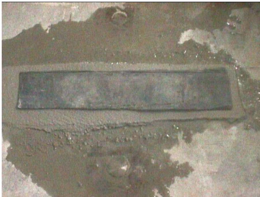
Figura 9.5 – Neoprene sobre a base nivelada, preparada para receber a parede
