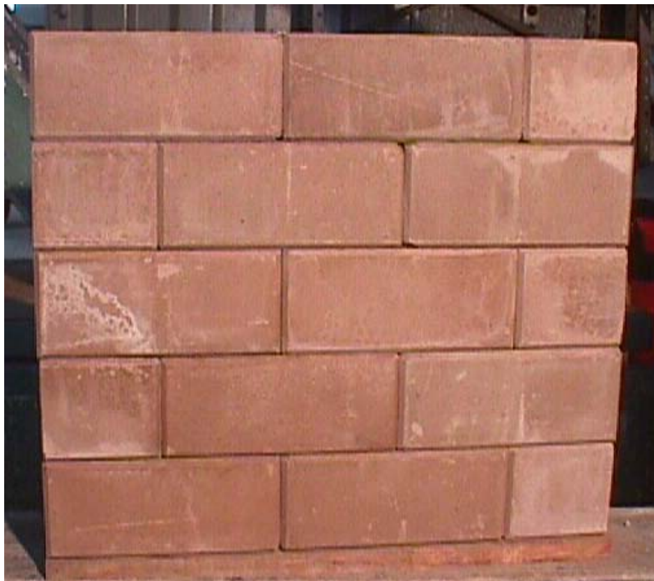
Figura 9.3 - Parede típica com cinco fiadas - em processo de cura
