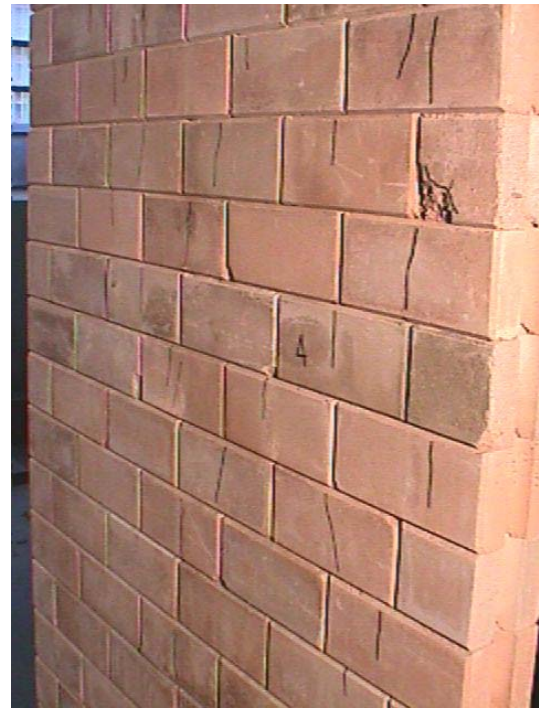
Figura A34 (à direita) – Fissuração da parede P2 com 24 fiadas, face sul central, durante a aplicação de carga. Observa-se um TJ 101 em processo de esmagamento
