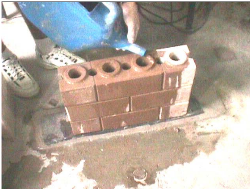
Figura 9.10 – Umedecimento das três fiadas, antes da injeção da argamassa
