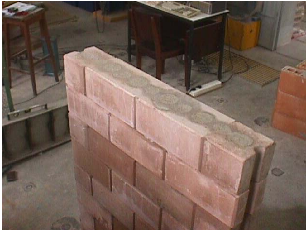
Figura 9.15 – Detalhe do acabamento dos furos da última fiada.
