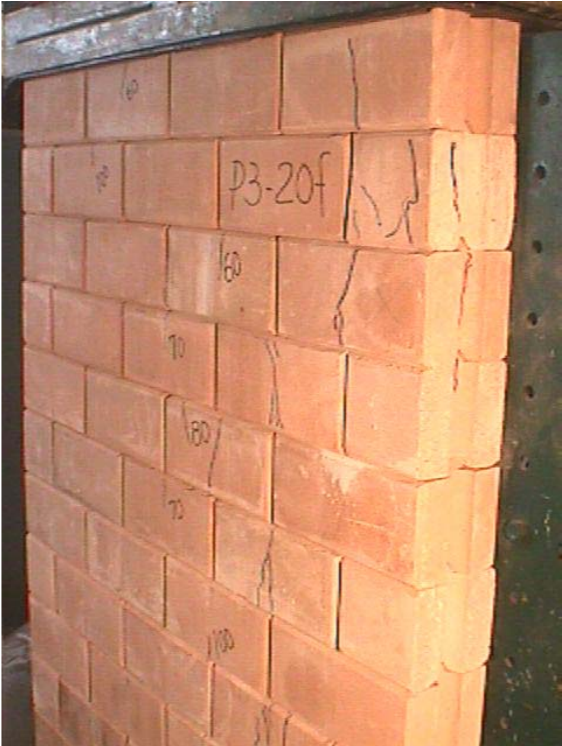
Figura A29 – Fissuração da parede P3 com 20 fiadas, face sul parte superior
