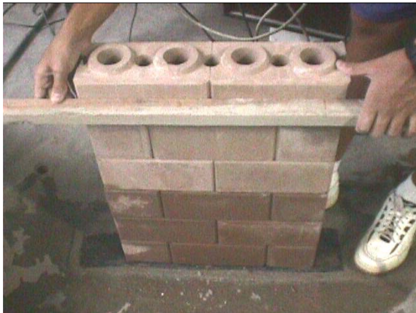
Figura 9.13 – Ajuste do alinhamento em mais três fiadas, antes da aplicação da argamassa nos furos pequenos
