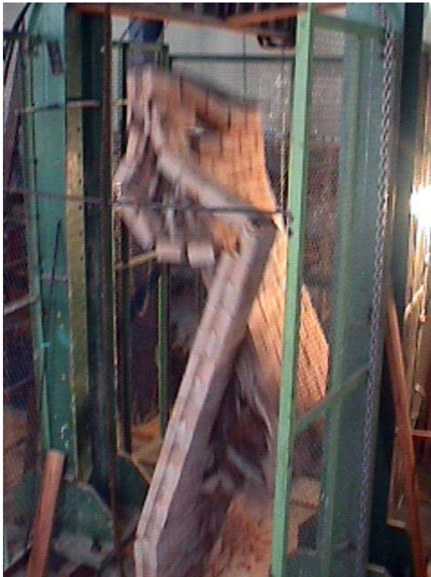
Figura 11.21 – Foto mostrando a queda de uma parede de 2,6 m de altura, após a ruptura dos septos centrais do tijolito. P1 [5x26]
