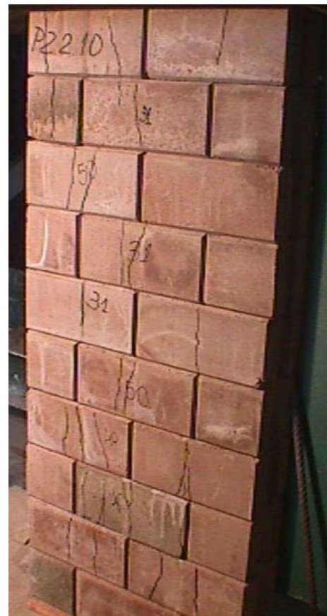
Figura A14 (à direita) – Fissuração da parede com 10 fiadas, após a carga máxima – P2 face sul
