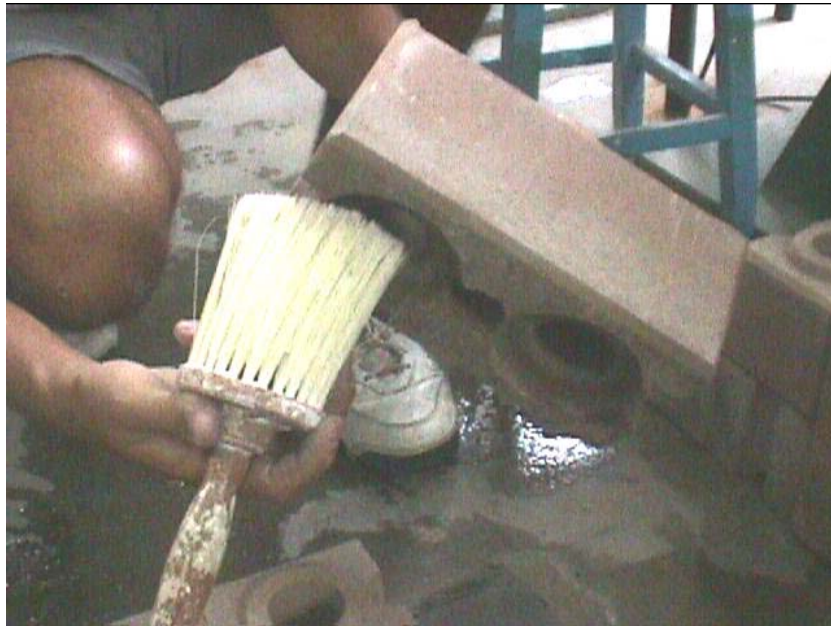
Figura 9.6 – Limpeza da parte inferior do tijolito, antes de montar a fiada
