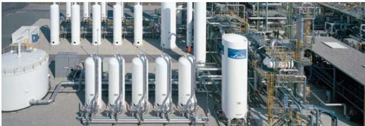
Figura 9 – Exemplo de uma planta típica de PSA, contendo uma série de colunas de adsorção. Fonte: Linde, 2018.
