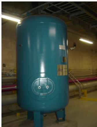
Figura 3.22 - Balão de ar para o sistema de regulação de velocidade.
