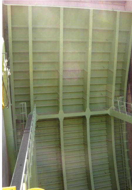
Figura 3.44 - Comporta do vertedouro.
