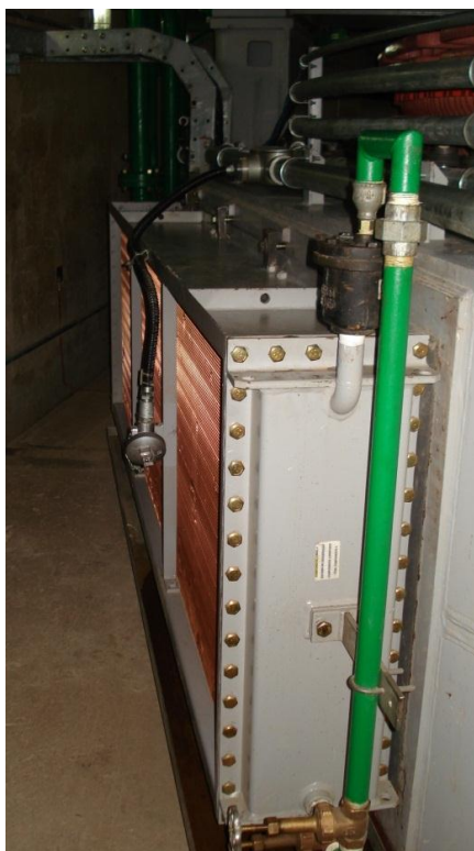
Figura 3.24 - Trocador de calor do gerador.
