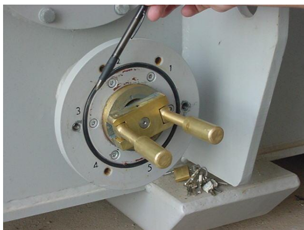
Figura 3.33 - Comutador de tapes.
