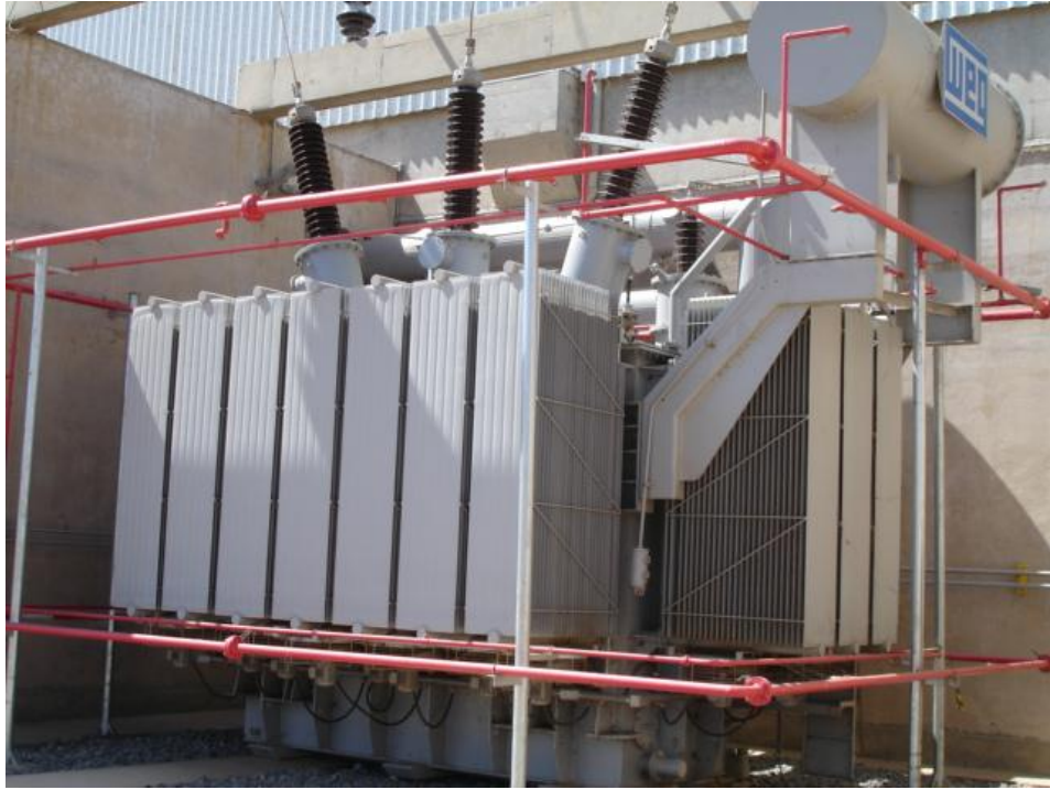
Figura 3.29 - Transformador elevador.
