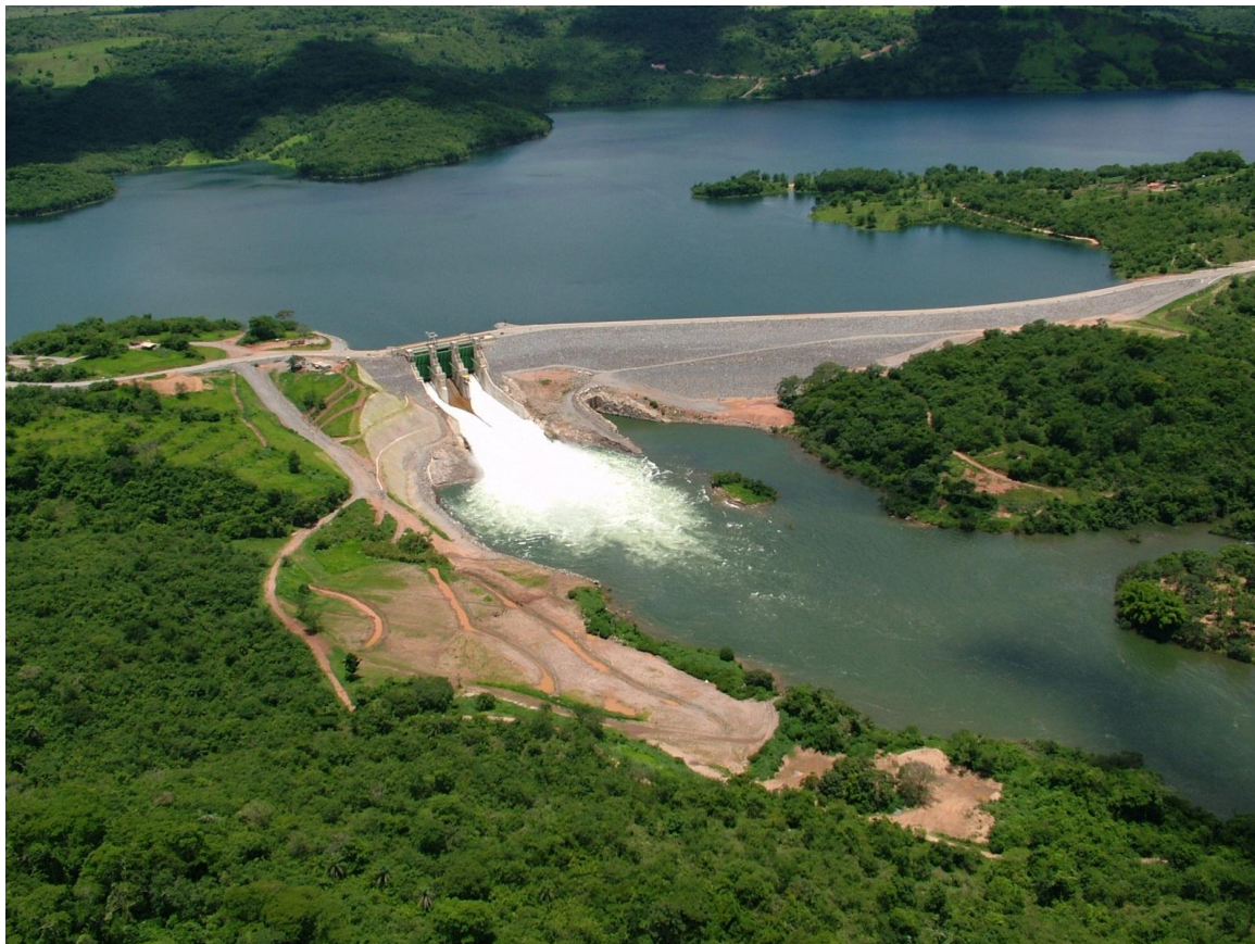
Figura 3.43 - Estrutura civil do vertedouro.
