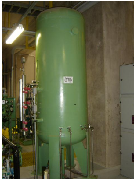
Figura 3.20 - Tanque ar-óleo para o sistema de regulação de velocidade.
