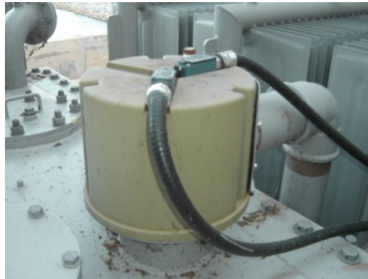
Figura 3.35 - Válvula de segurança.
