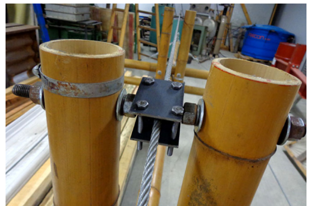
Figura 16. Perspectiva do clip fixando o cabo de aço. Fonte: o próprio autor.
