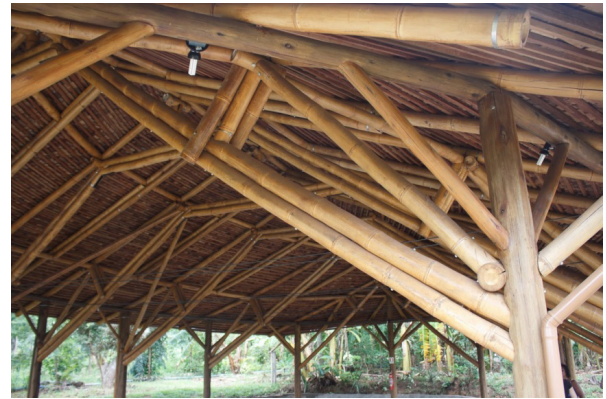
Figura 33. Colunas compostas utilizadas no Sindicato Professores SINPRO-DF.
