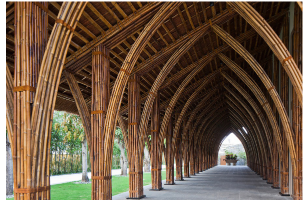
Figura 41. Uso de colunas em feixe, Sala de Conferências Naman Retreat, Vietnã Fonte: Vo Trong Nghia Architects.
