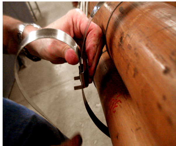
Figura 20. instalação cinta metálica e da trava na cinta ao redor da coluna. Fonte: o próprio autor.
