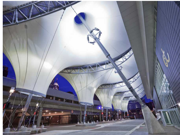
Figura 29. Estruturas metálicas utilizadas em tensionadas. Fonte: Bambutec.com.br, e Estação Rosa Park em Michigan (EUA)
