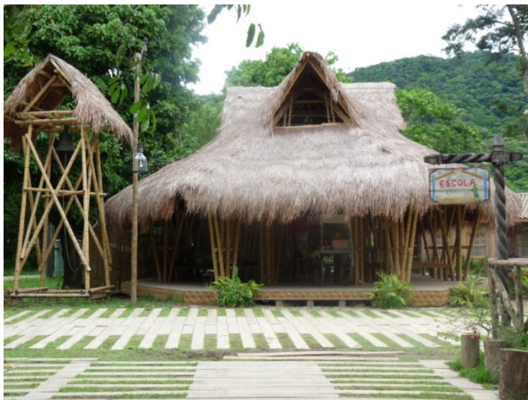
Figura 31. Aspecto da capela do cenário, e uso de colunas compostas. Fonte: Arte Desenho Construtora, Rio de Janeiro, RJ.
