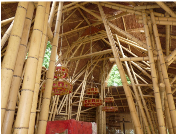
Figura 32. Aspecto da capela do cenário, e uso de colunas compostas. Fonte: Arte Desenho Construtora, Rio de Janeiro, RJ.
