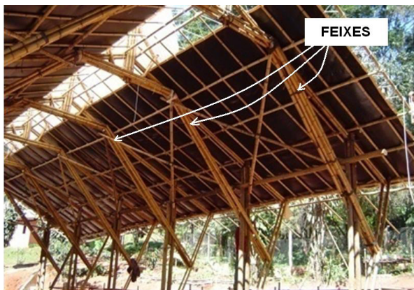
Figura 40. Exemplo de aplicação de colunas em feixe em estrutura. Fonte: Instituto Kairós, Distrito de Macacos, Nova Lima (MG).
