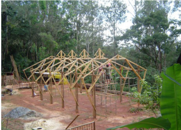
Figura 39. Exemplo de aplicação de colunas em feixe em estrutura. Fonte: Instituto Kairós, Distrito de Macacos, Nova Lima (MG)
