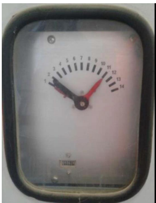
Figura B.3 – Caso 2 - Indicador de Posição dos Tapes.
