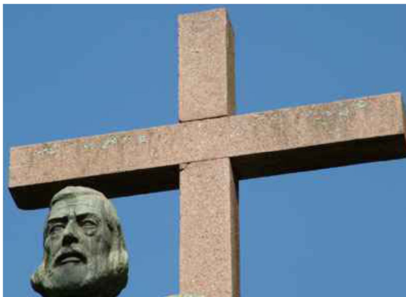
Fig. 10. Colonização biológica diagnosticada com a alteração da coloração no monumento: Os fundadores de São Paulo.
