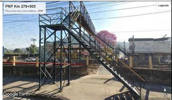
Figura 28: Passarela e PNP no km 279
