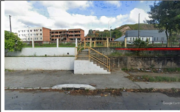
Figura 23: PNP inaccessível no km 282
