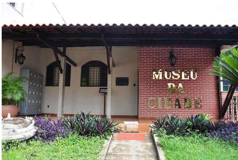
Figura 1 - Fachada do Museu da Cidade – GV
