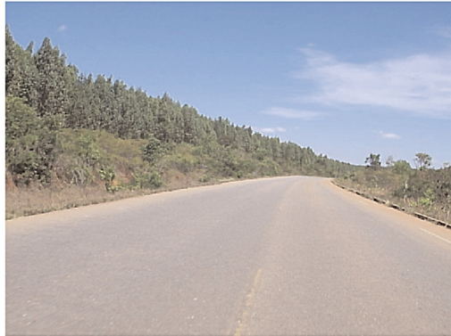
Estrada asfaltada do alto da chapada na saída de Capelinha.
