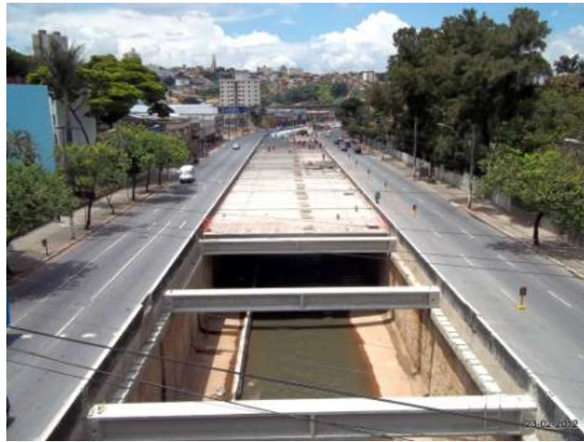
Fig. 18 - Projeto viário de exclusão dos rios, exemplo do BULEVAR / BH, mostrando o esgoto no leito do antigo ribeirão Arrudas 68 Acervo PMz.
