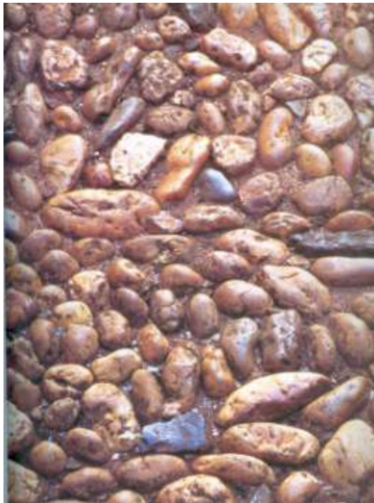
Fig. 19 - Seixos rolados, produtos dos rios , vindo do rio das Velhas, piso da Casa da Intendência e Fundação de Sabará, atual Museu do Ouro, sec.XVIII. Fotografia Cuia Guimarães, Acervo PMz
