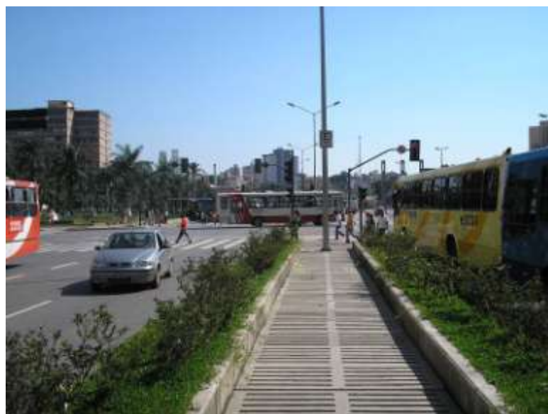
Fig. 17- Bulevar no centro da capital de Minas Gerais, obras recentes de urbanização 66 do ribeirão Arrudas 67 . Acervo PMz.
