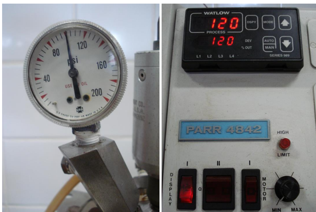
Figura 4.3: Controladores de pressão e temperatura, respectivamente
