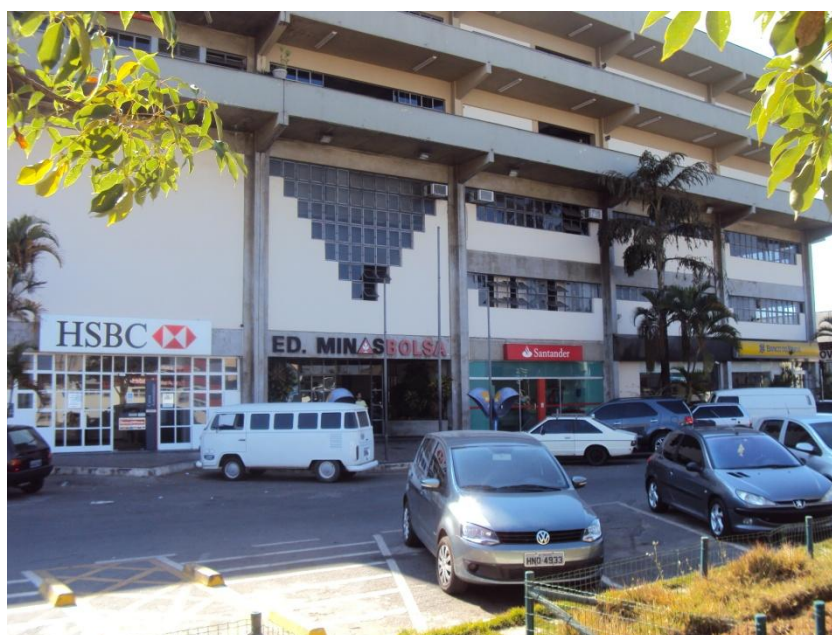
FIGURA 07 - Centro de Serviços / Localizado na CEASA.
