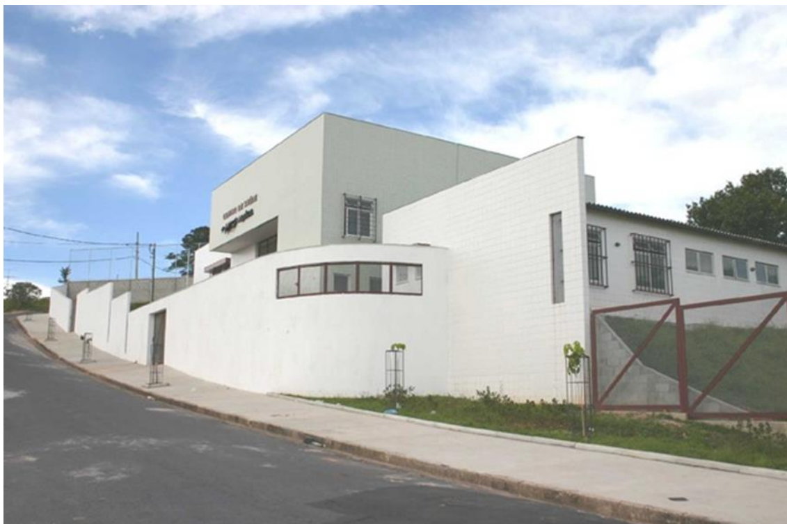
Figura 1 - Centro de Saúde Marcelo Pontel Gomes
