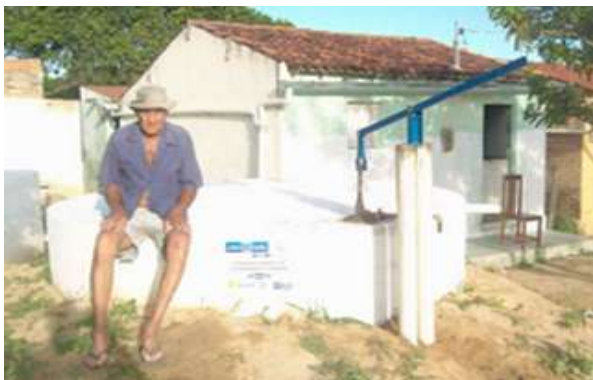
Foto 23 – Bomba d'água Trampolim
