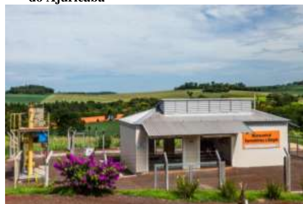
Foto 11 – Microcentral Termelétrica a Biogás do Ajuricaba
