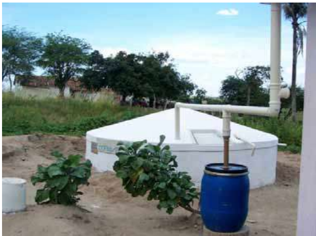
Foto 16 – Cisterna pronta com placas pré-moldadas
