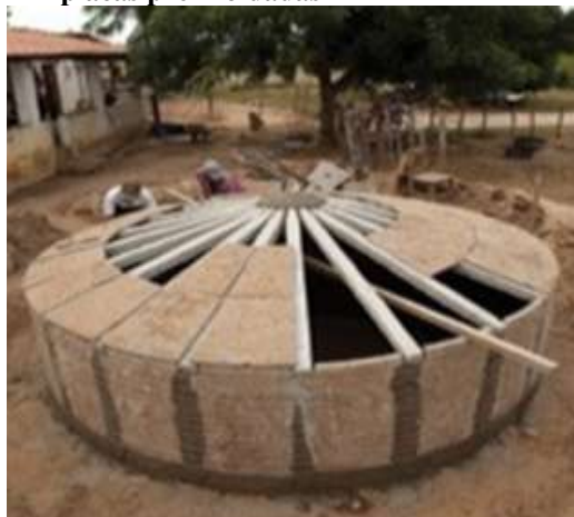
Foto 17 – Construção da cobertura com placas pré-moldadas
