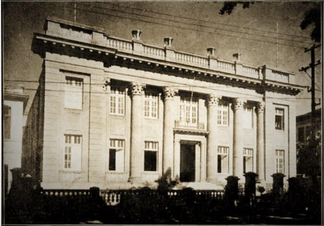
Figura 3 - O prédio do Conservatório Mineiro de Música, hoje tombado pelo Instituto Estadual do Patrimônio Histórico e Artístico de Minas Gerais (IEPHA/MG).
