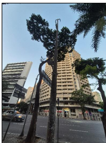
Figura 16 – Poste concreto H=18m
