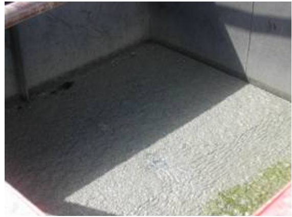
Figura 5.2 – Vista da camada de espuma acumulada durante a fase 2 (decantador do R1)
