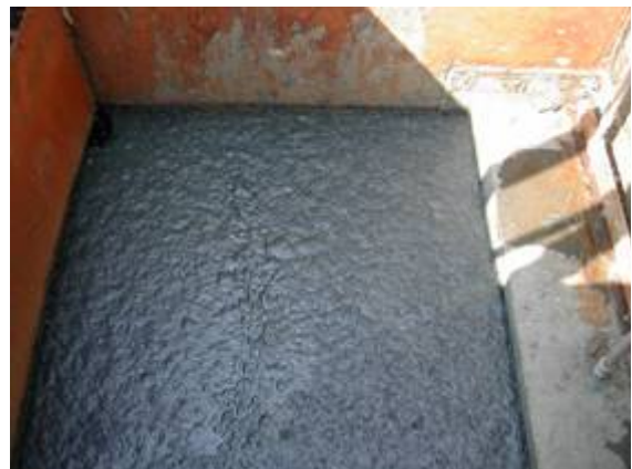
Figura 5.4 – Vista da camada de espuma acumulada durante a fase 4 (decantador do R1)
