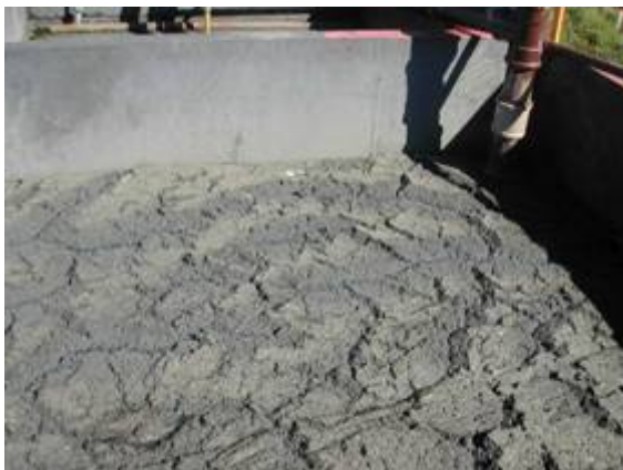
Figura 5.3 – Vista da camada de espuma acumulada durante a fase 3 (decantador do R2)
