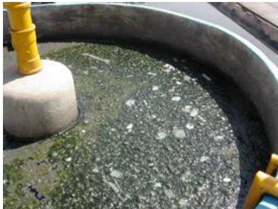
Figura 5.5 – Vista da camada de espuma acumulada no decantador do reator R3
