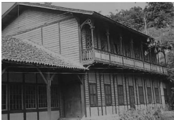
FIGURA 64: Casa das máquinas de beneficiamento de café e cereais da Fazenda Fortaleza de Santana.
