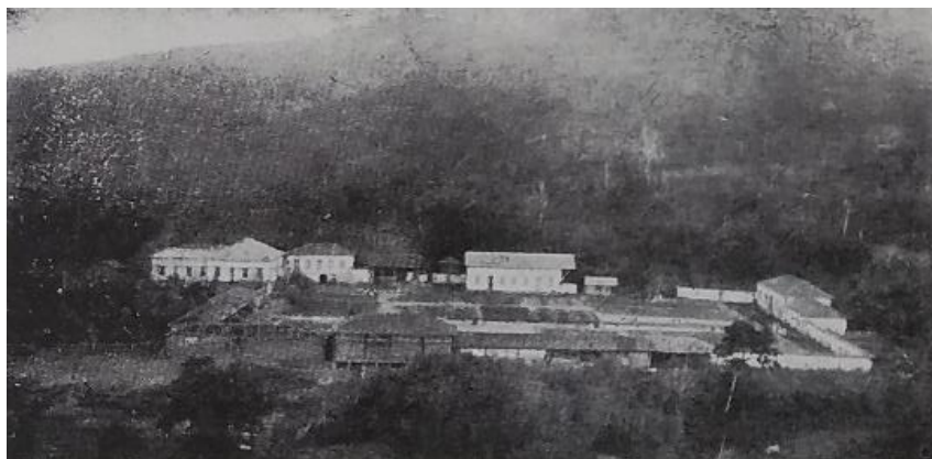
FIGURA 67: Conjunto Arquitetônico da Fazenda Passo da Pátria.
