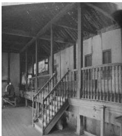
FIGURA 65: Tulha com escada de madeira preservada na Fazenda Boa Esperança.
