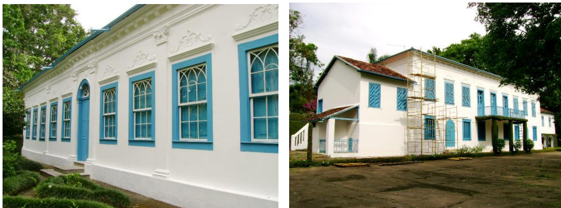
FIGURA 53 e 54: Edifício-sede da Fazenda Mundo Novo
