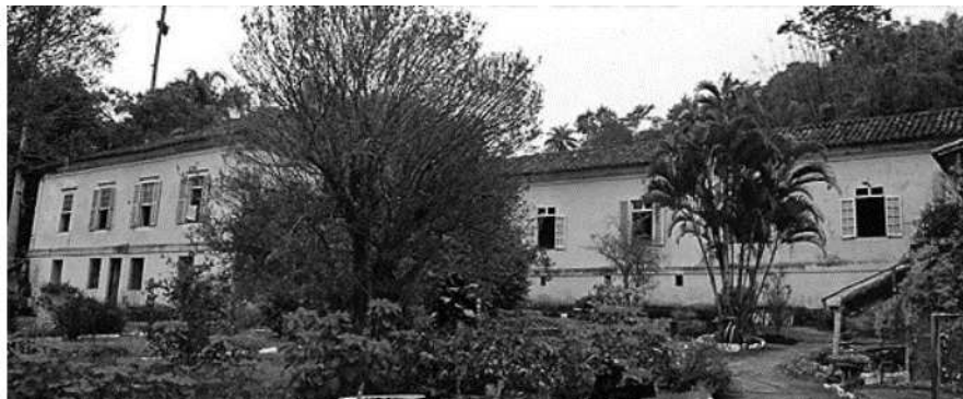
FIGURA 59: Edifício sede da Fazenda Santa Sofia.
