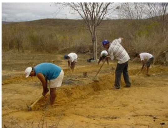
Figura 37: Construção dos camalhões em curva de nível (julho/2005)
