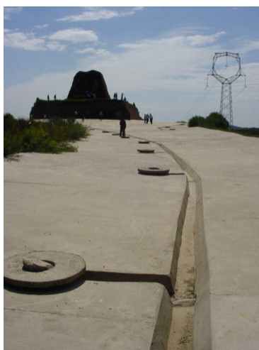
Figuras 9 e 10: Captação de água de chuva em cisternas e macrocaptação por escoamento para agricultura na província de Gansú, China
