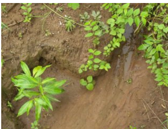
Figura 90: Saturação da camada superficial de solo e encharcamento após chuva na AE1 (março/2006)
