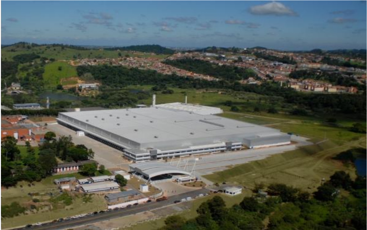
Figura 1 - Centro de Distribuição da AVG - Matriz em Vinhedo / SP
