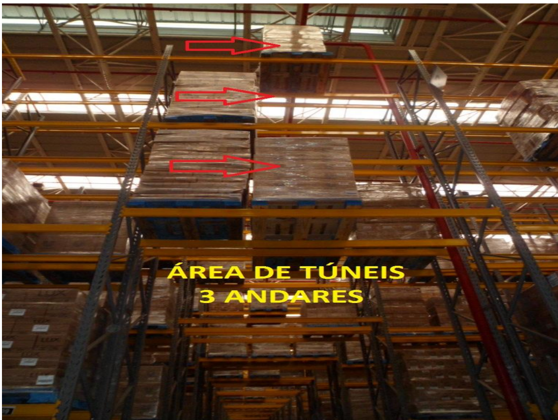
Figura 6 - Estrutura porta pallet – túnel depois da ampliação
