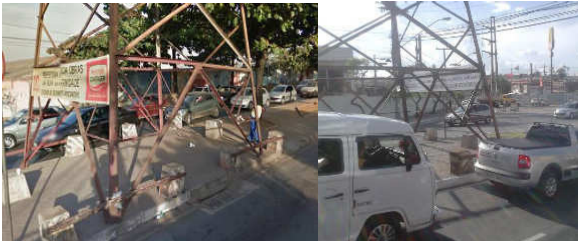
Figura 3.4: Torre de transmissão do bairro Cidade Industrial (2010/15) - Contagem. (Fonte: GoogleMaps / Arquivo pessoal)
