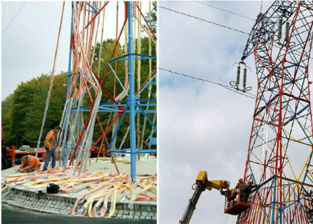
Figura 5.4: Processo de transformação da torre. (CIGRE, 2007)
