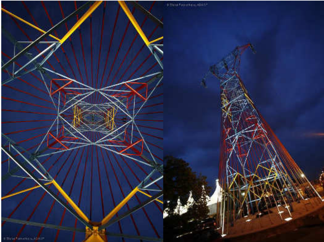
Figura 5.3: Torre de transmissão de 225 kV na cidade de Amnéville les Thermes– França, que recebeu uma intervenção feita pela artista Elena Paroucheva. (Fonte: www.electric-art.eu )
