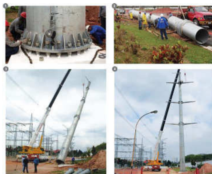
Figura 2.3: Processo de montagem da torre monotubular. (SECCIONAL[26])
