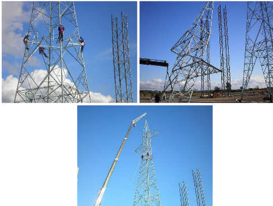
Figura 2.4: Processo de montagem da torre treliçada. (Adaptado de OLIVEIRA[26])
