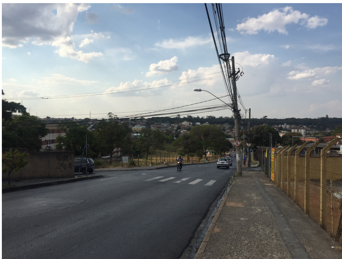
Figura 01: Avenida Serrana – a principal via do bairro Serrano. Foto do autor. Fonte: arquivo pessoal
