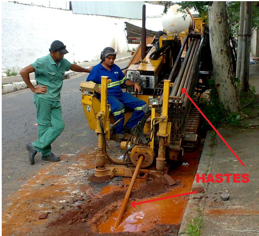
Figura 3.28: Perfuratriz HDD de médio porte do fabricante Vermeer.
