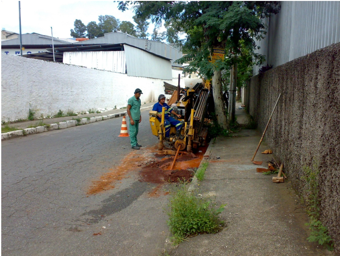
Figura 4.3: Posicionamento dos equipamentos para a realização da obra.
