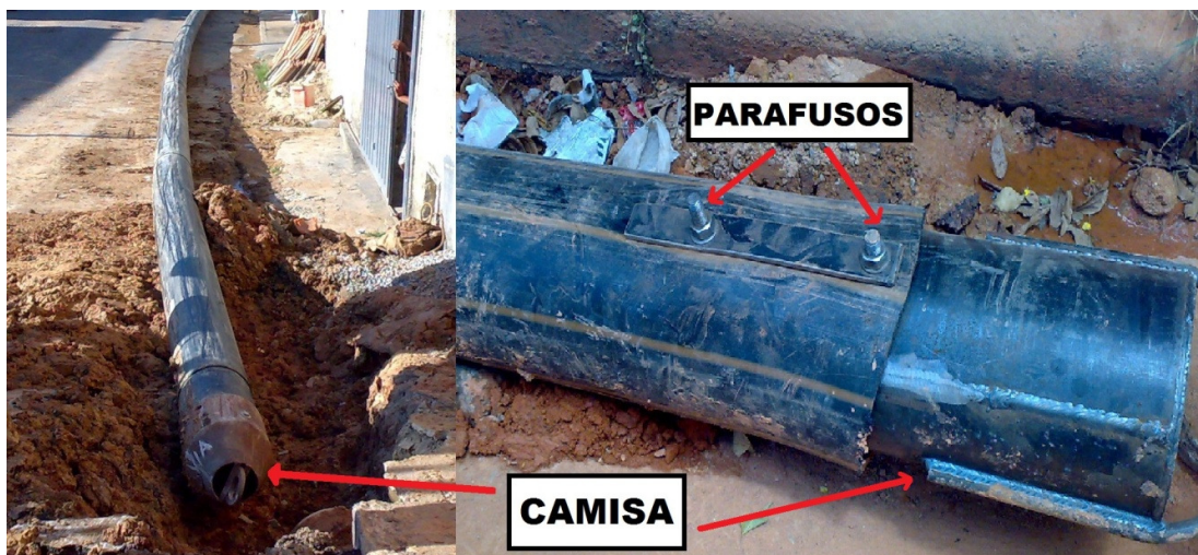
Figura 3.34: Camisa/cabeça de puxamento com fixação do tubo através de parafusos.
