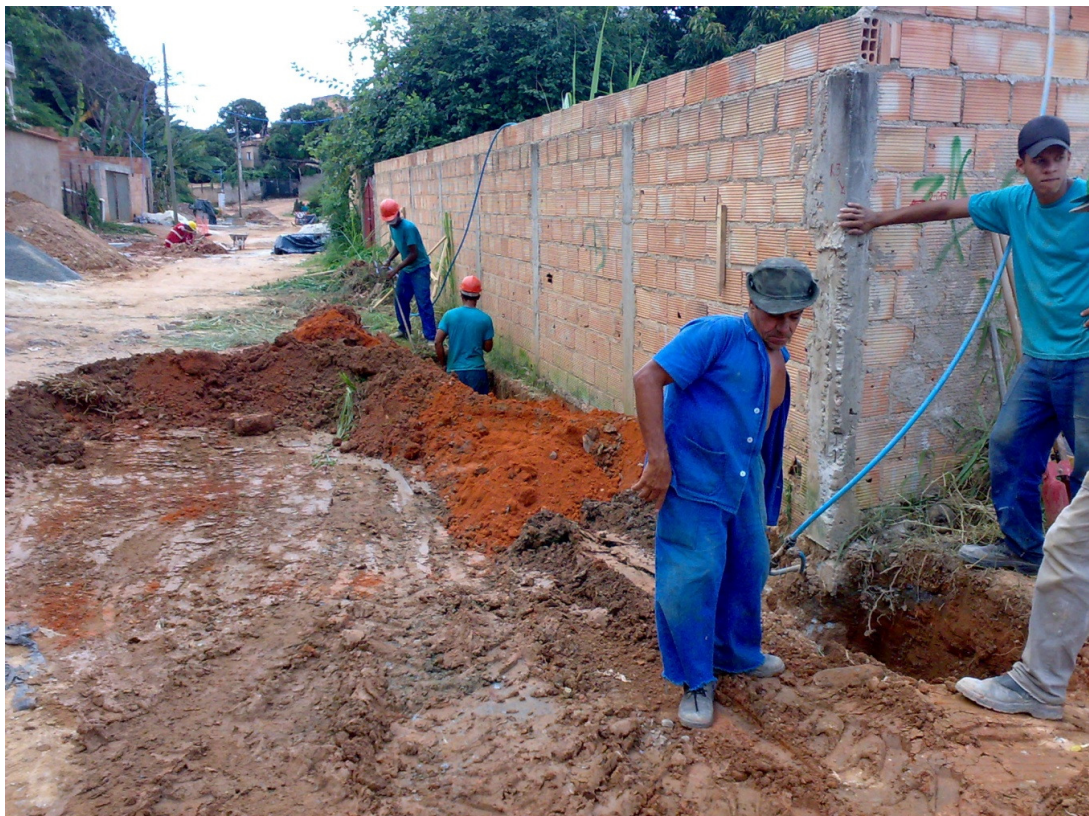
Figura 3.5: Foto de uma escavação manual de vala em Belo Horizonte.
