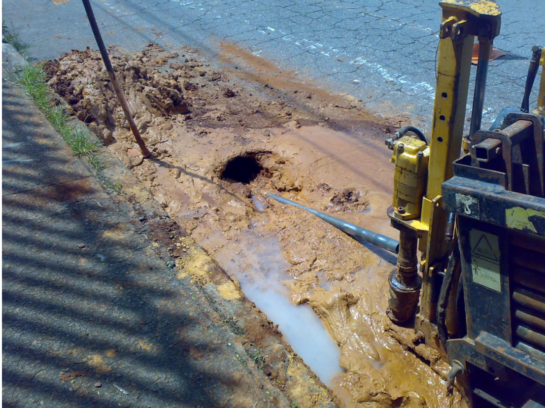
Figura 4.4: Lama resultante da perfuração
