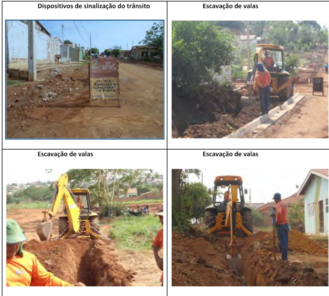
Figura 3.2: Etapas iniciais da obra.
