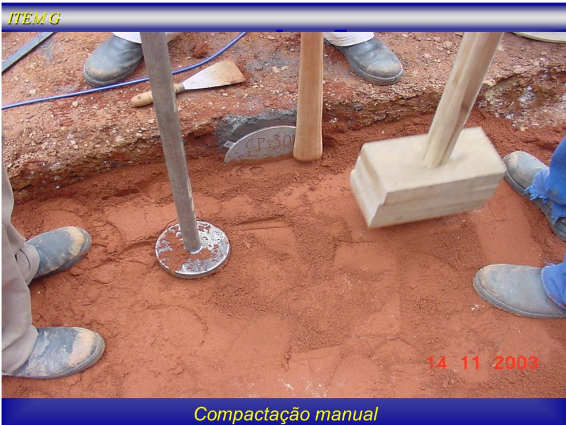
Figura 3.7: Exemplo de compactação manual do solo.
