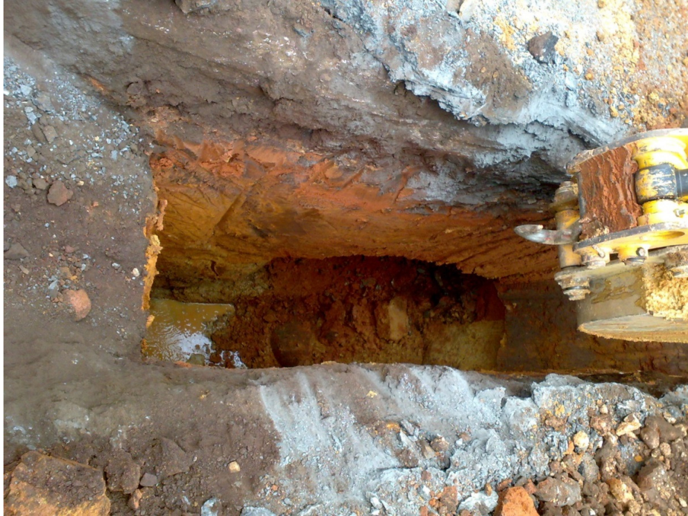
Figura 4.8: Abertura de poço auxiliar.
