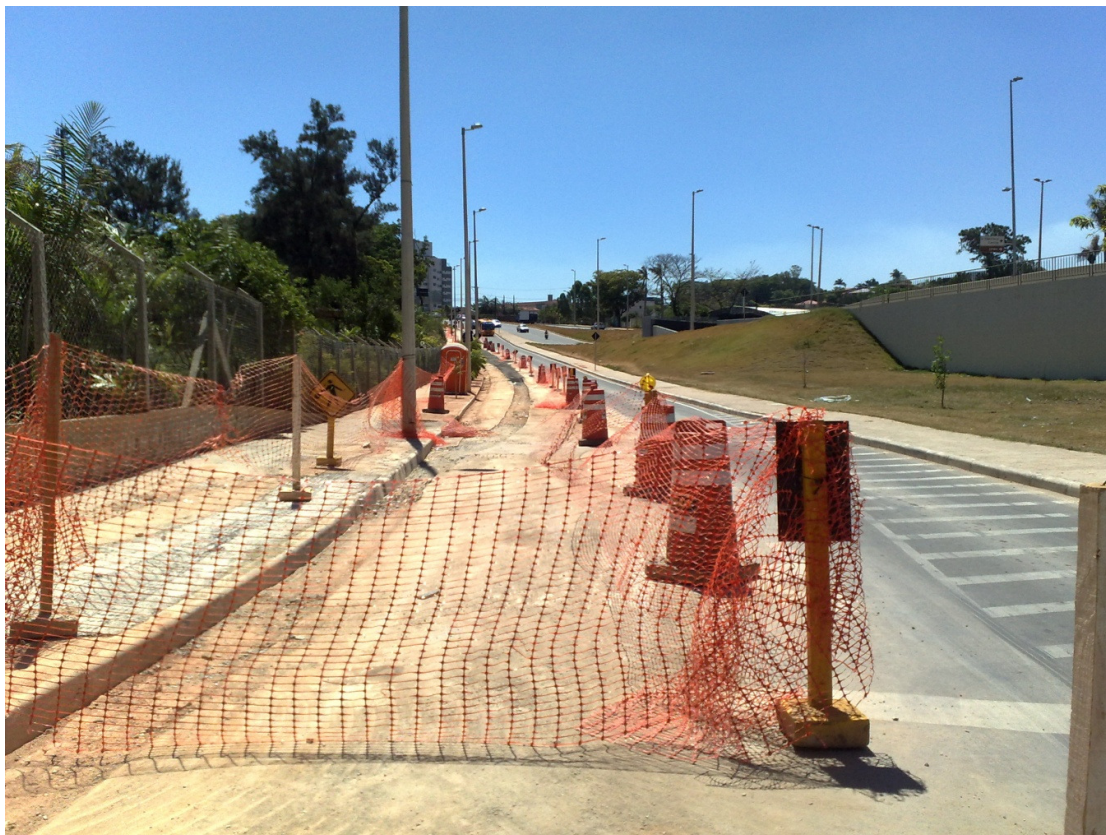
Figura 3.8: Sinalização, reaterro e recomposição de pavimento asfáltico
