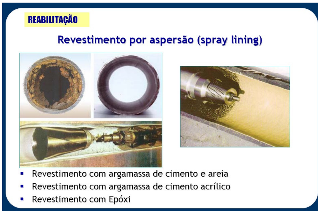
Figura 3.14: Aplicação do spray lining .
