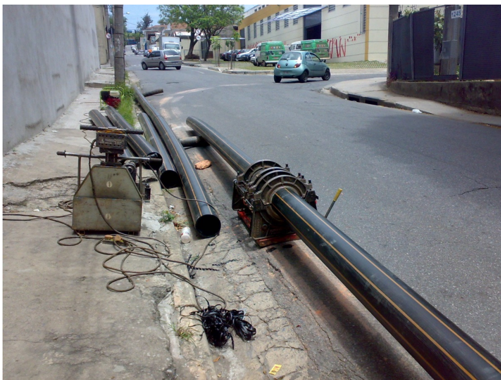
Figura 4.6: Solda dos tubos de PEAD por termofusão.
