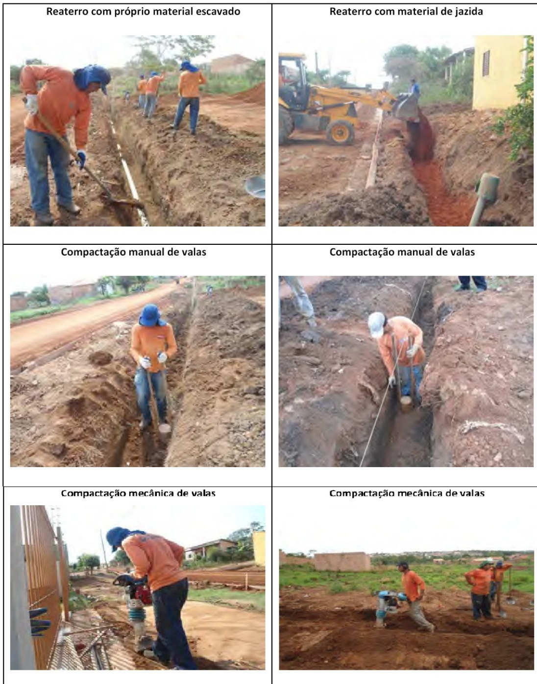
Figura 3.4: Etapas finais da obra.
