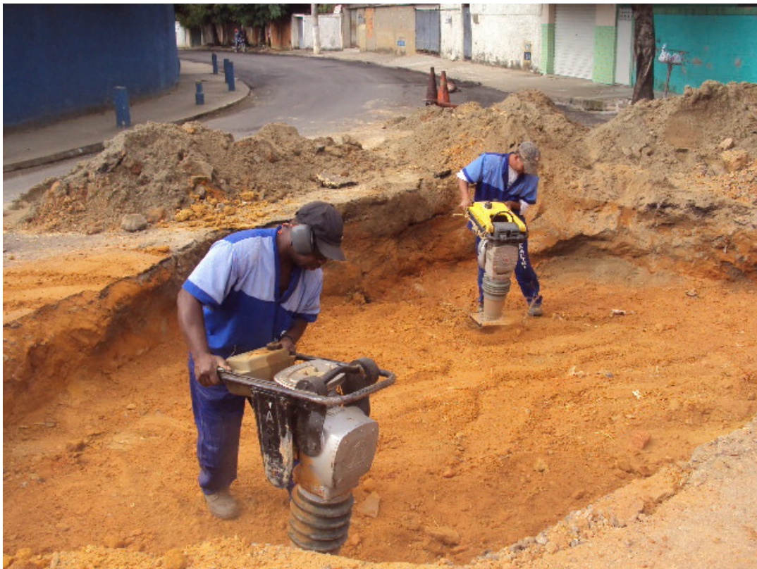
Figura 3.6: Execução de compactação mecanizada.
