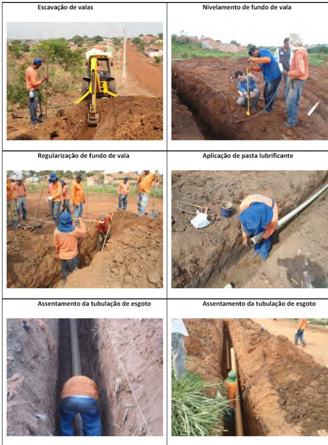
Figura 3.3: Etapas intermediárias da obra.
