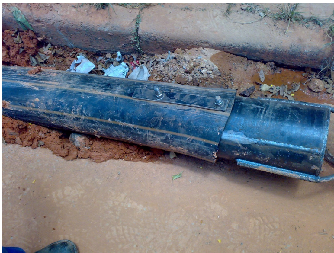
Figura 4.7: Fixação do tubo na cabeça de puxamento.
