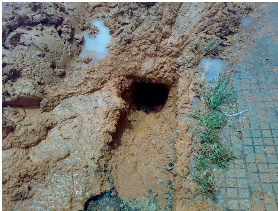
Figura 4.5: Finalização de um pré-argamento.
