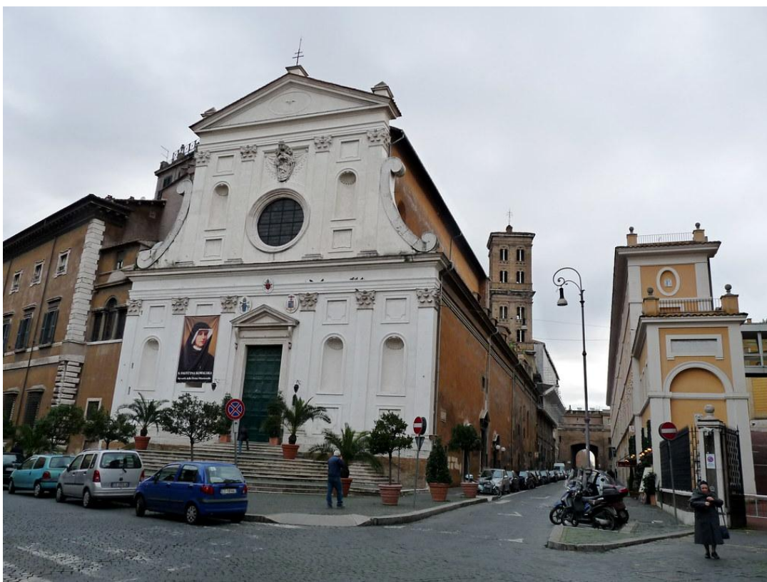
Figura 9: Imagem da fachada revitalizada do Santuário. Foto: Dan
