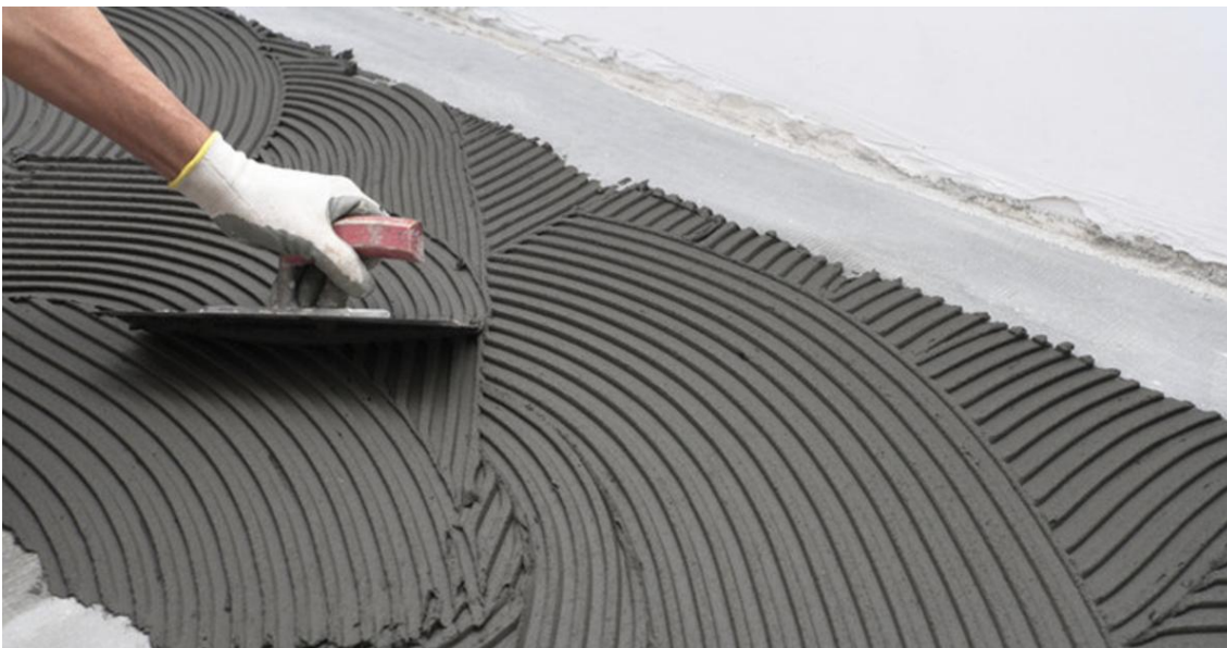
Figura 8: Exemplo de argamassa para assentar piso.
