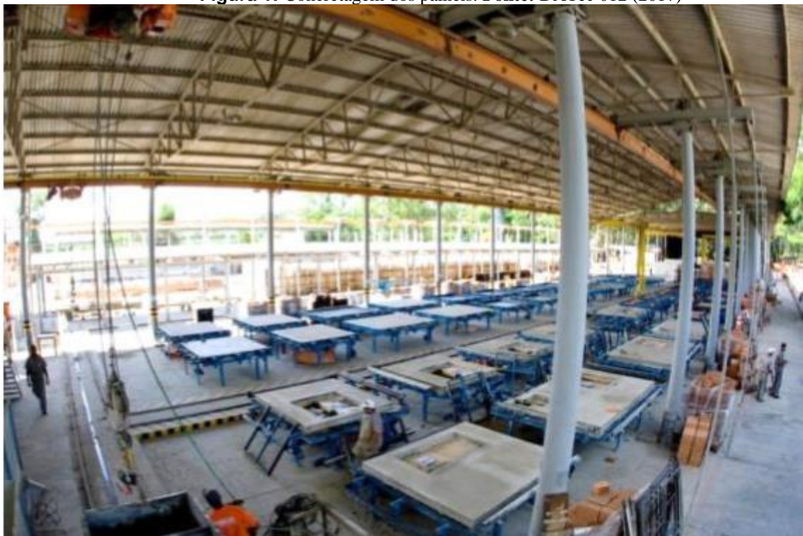
Figura 1: Concretagem dos painéis. Fonte: DATec 012 (2017)
