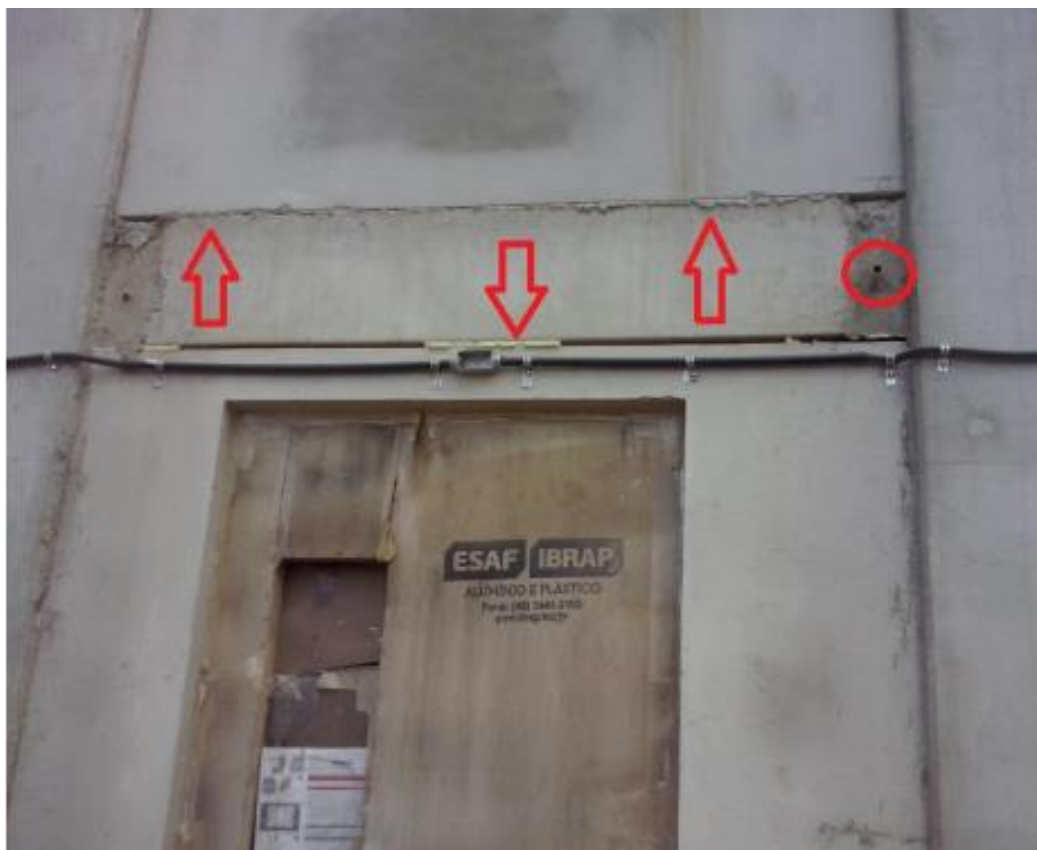
Figura 6: Junta provocada pela placa de EPS após a montagem dos elementos. Fonte: Arquivo Pessoal
