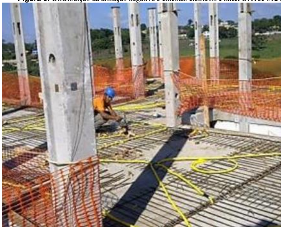
Figura 5: Distribuição da armadura negativa e chicotes elétricos. Fonte: DATec 012 (2017)
