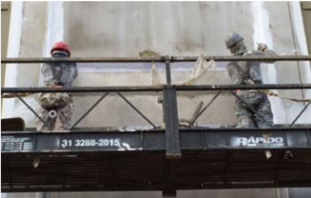
Figura 18: Junta durante a aplicação da 1ª demão. Fonte: Arquivo Pessoal
