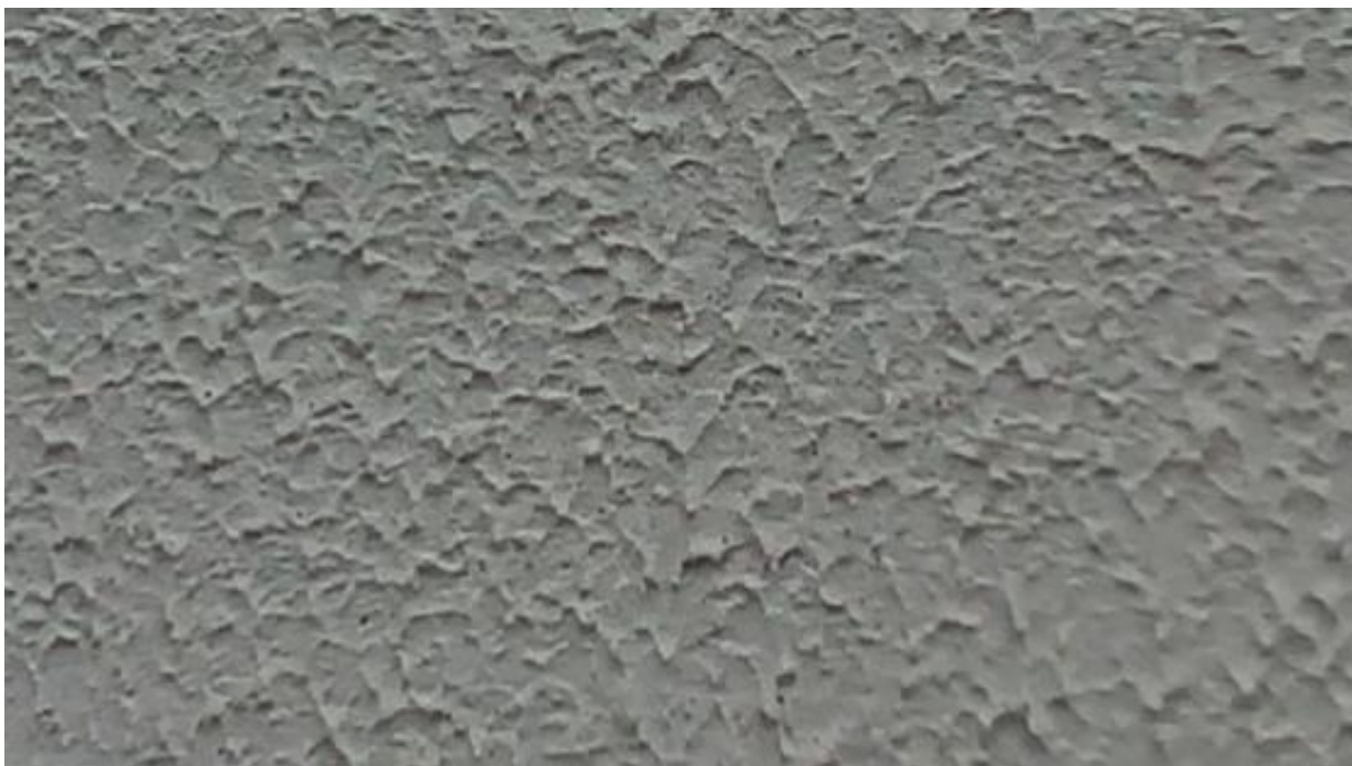
Figura 15: Micro-furos causados por excesso de diluição. Fonte: Arquivo Pessoal
