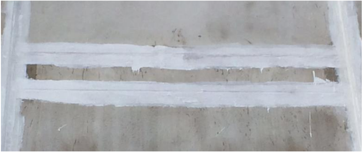
Figura 19: Junta depois da aplicação das 03 demãos + tela. Fonte: Arquivo Pessoal
