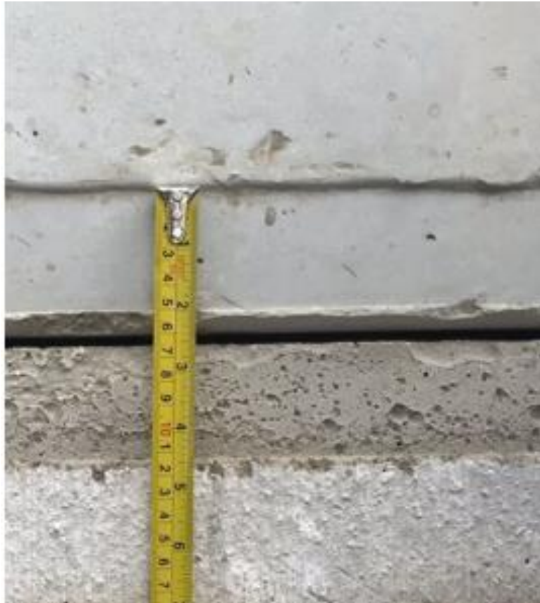
Figura 17: Junta antes da aplicação da 1ª demão. Fonte: Arquivo Pessoal
