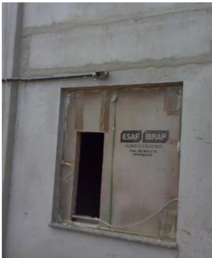
Figura 7: Interface dos elementos pré-fabricados encunhada. Fonte: Arquivo Pessoal
