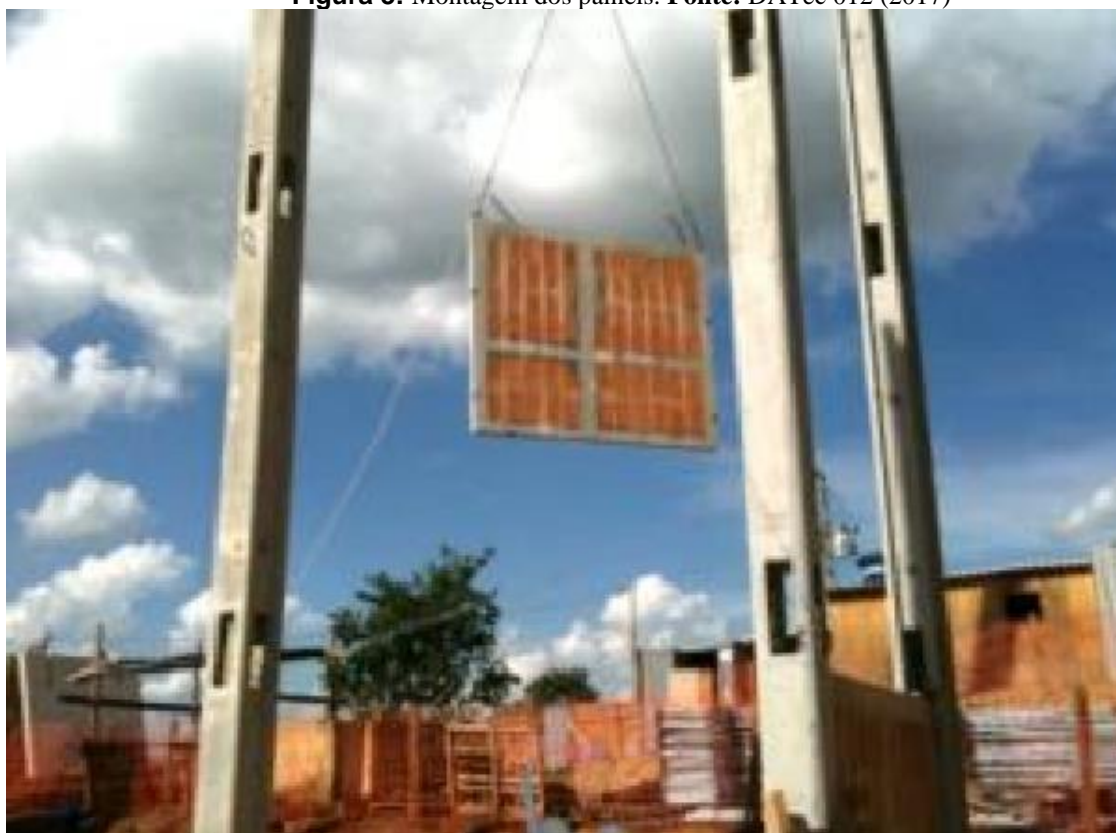
Figura 3: Montagem dos painéis. Fonte: DATec 012 (2017)
