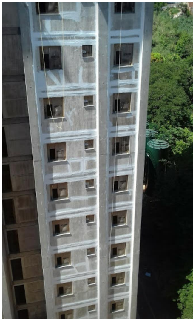
Figura 20: Vista da fachada impermeabilizada e com trincas e fissuras tratadas.
