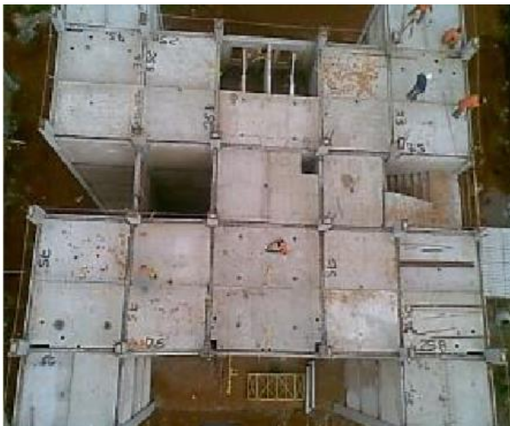
Figura 4: Montagem das pré-lajes. Fonte: DATec 012 (2017)
