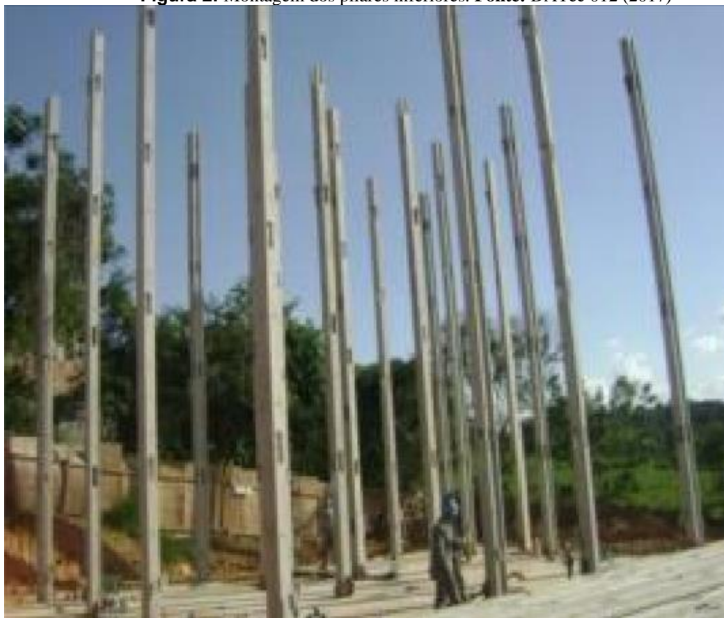
Figura 2: Montagem dos pilares inferiores. Fonte: DATec 012 (2017)
