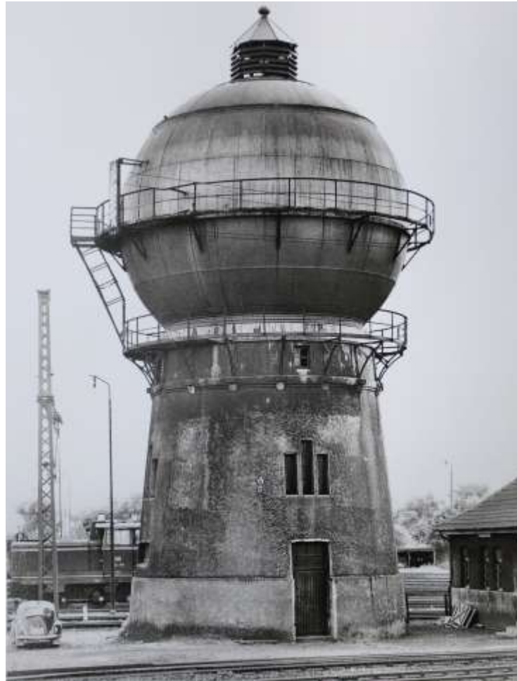
Figura 59: Torre de caixa d'água, Alemanha, 1965
