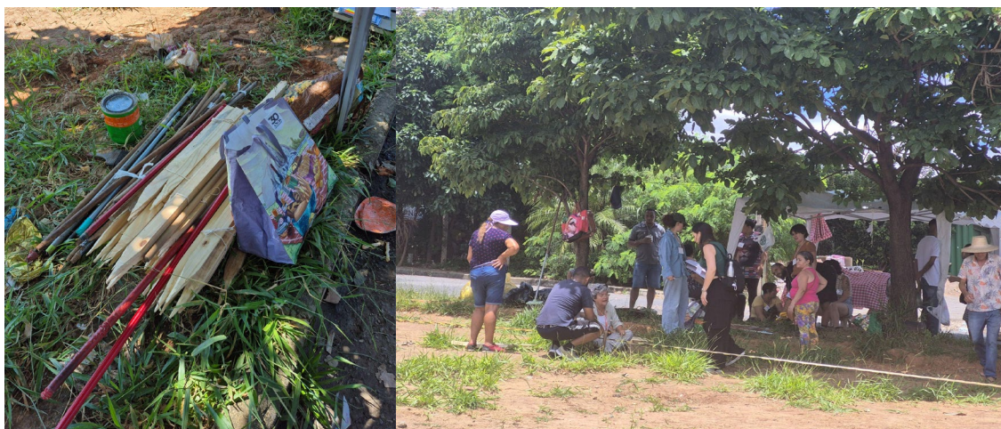
Figura 23 – Estacas e outros materiais para a atividade (à esquerda) e equipe realizando medição para marcação dos pontos a serem estaqueados (à direita)
