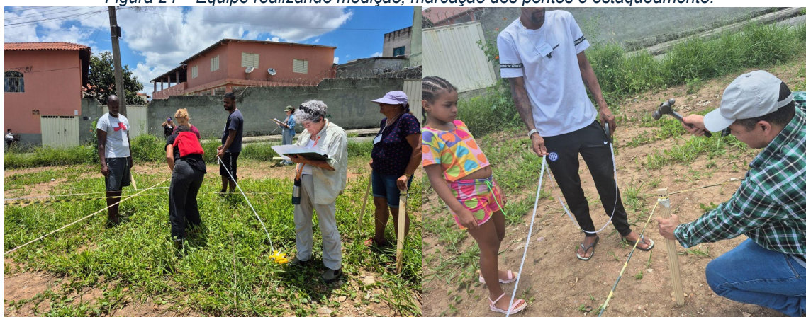
Figura 24 – Equipe realizando medição, marcação dos pontos e estaqueamento.
