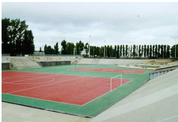
Figura 7- Bacia de retenção na bacia Maurice Audin – França
