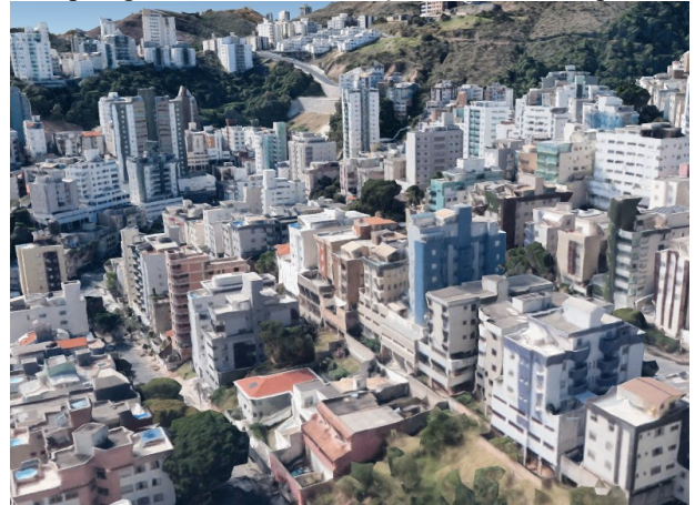
Figura 31 – Imagem aérea do Bairro Buritis onde se pode verificar os espaçamentos de fundos entre edificações localizadas em terrenos de alta declividade e a tipologia edilícia de construções baixas e compactas
