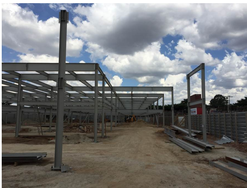
Figura 40: Foto do canteiro de obras durante a montagem das estruturas em aço do caso B2.
