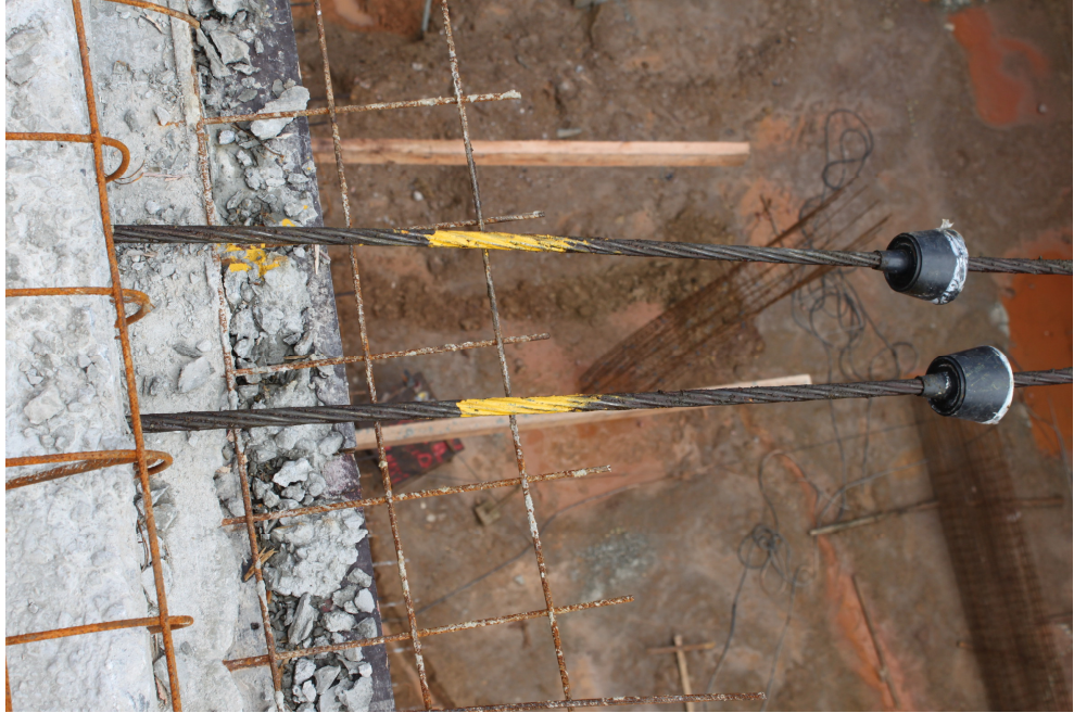
FIGURA 3.6 – Marcação das cordoalhas após a protensão.
