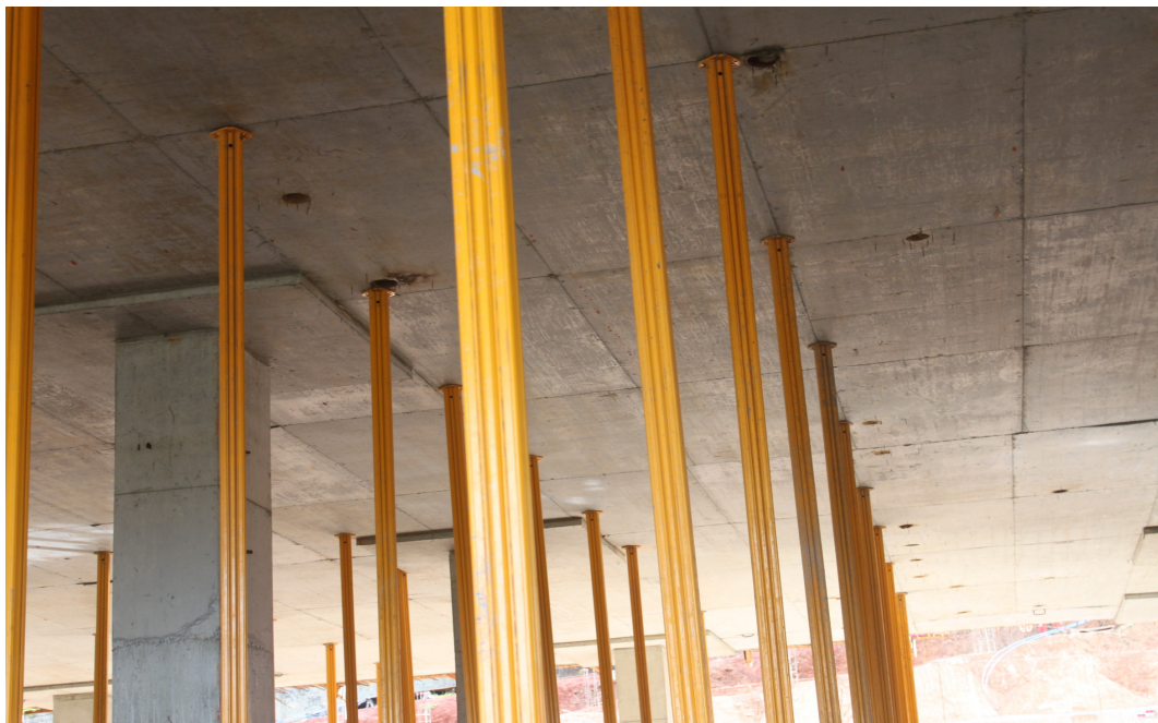
FIGURA 3.1 – Grandes vãos proporcionados pela laje protendida.
