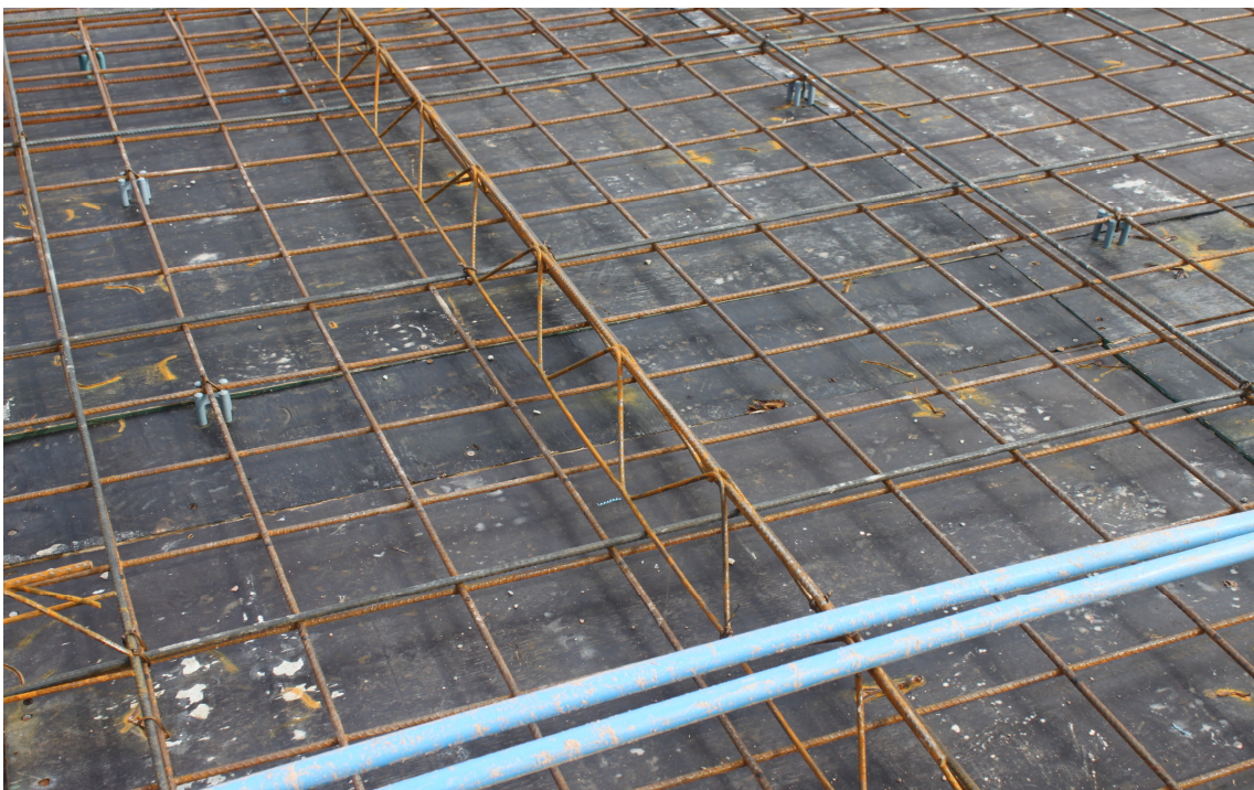
FIGURA 2.15 – Sistemas de apoio para armadura convencional “cadeirinhas” e treliças para apoiar as cordoalhas.
