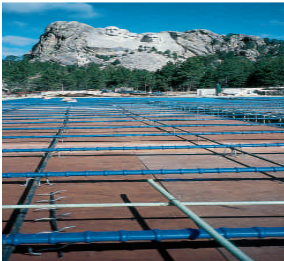
FIGURA 2.10 Laje com Protensão Aderente – Monte Rushmore – USA
