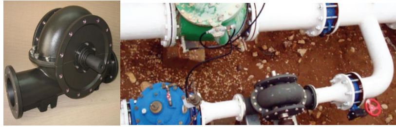
Figura 3.14– Turbina Leviathan benkatina OG2. Fonte: [37][42].
