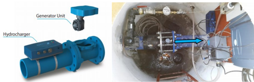
Figura 3.18– Turbina Hidro Spin em Israel.
