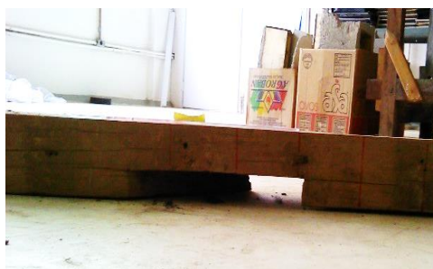
Figura 75: Região 4 onde encontra-se o entalhe da ligação entre o caibro 1 e a linha alta 1. Fonte: Autora, 2017.
