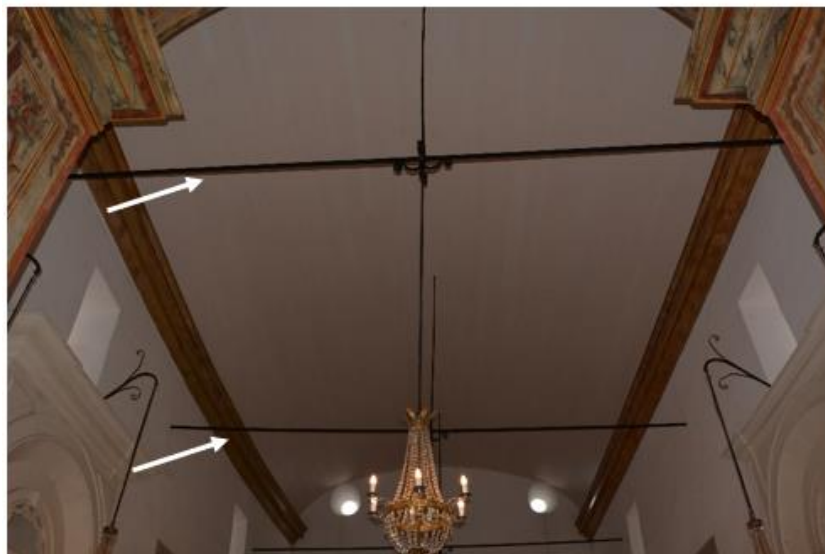
Figura 10: Reforço estrutural em ferro fundido na nave da Igreja de São José em Ouro Preto, Minas Gerais.
