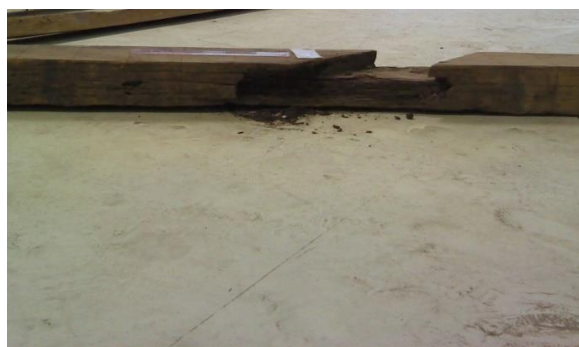
Figura 95: Região 9 onde localiza-se a ligação entre o caibry 2 e a linha alta 1.
