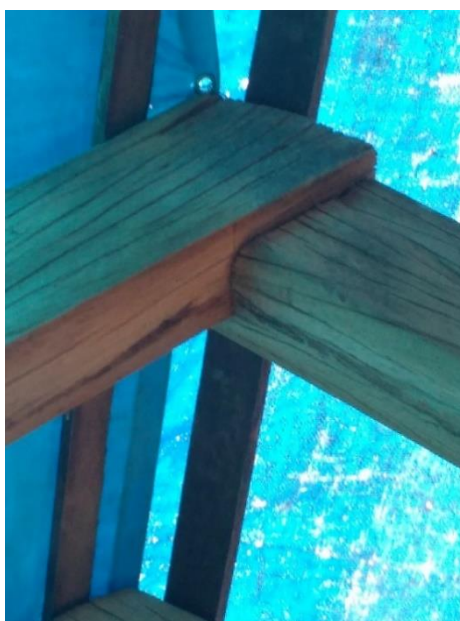
Figura 25: Entalhe na ligação superior das pernas da tesoura de caibro-armado da Igreja do Santíssimo Sacramento de Jequitibá, Minas Gerais.
