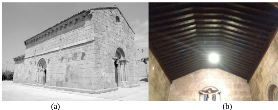
Figura 21: (a) fachada frontal da Igreja do Salvador de Cabeça Santa; (b) tesouras de caibro armado da cobertura com vão de 8,5 metros.
