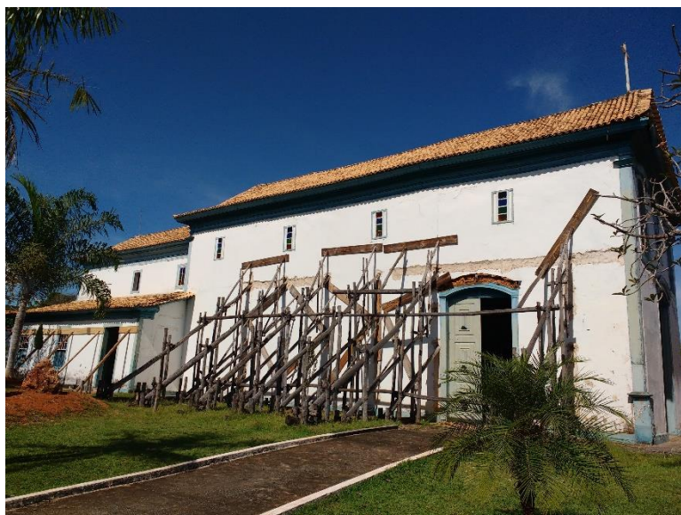
Figura 40: Vista da fachada lateral esquerda da Igreja Matriz do Santíssimo Sacramento. Jequitibá-MG. Fonte: Autora, 2017.
