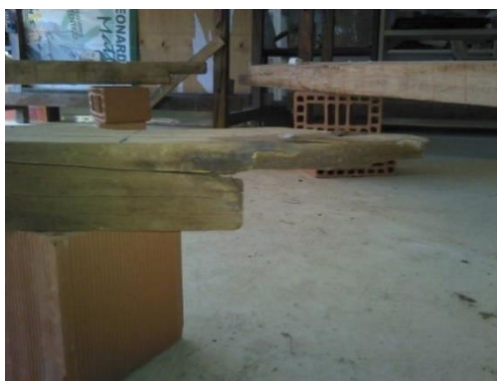
Figura 111: Ligação direita entre a linha alta 1 e o caibro 2.
