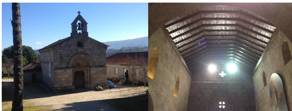
Figura 19: (a) Fachada da Igreja de Santo Isidoro de Canaveses; (b) Tesouras de caibro-armado com vão de 7,40 metros.
