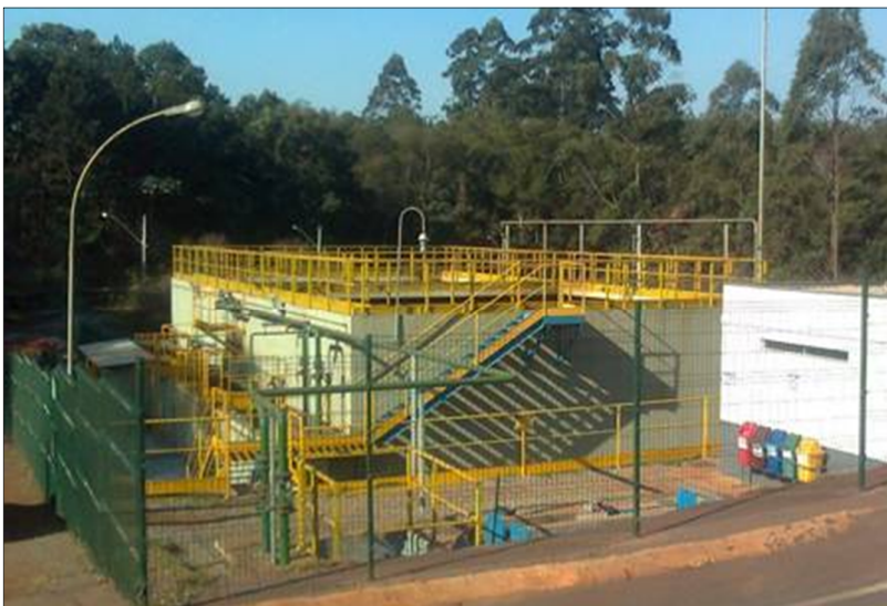
FIGURA 4.1 – Vista ETE Cauê
