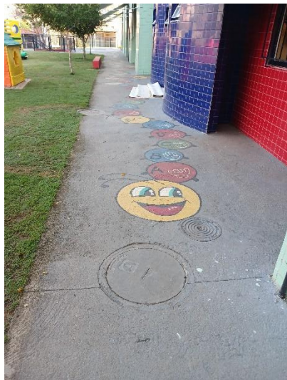
Foto 6: Chão Lateral do Refeitório
