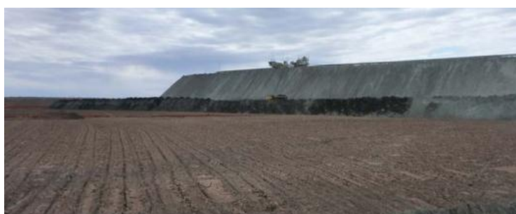
Figura 3.7. Co-disposição de rejeito e estéril na planta da Karara Mining (LUPPNOW, 2014).
