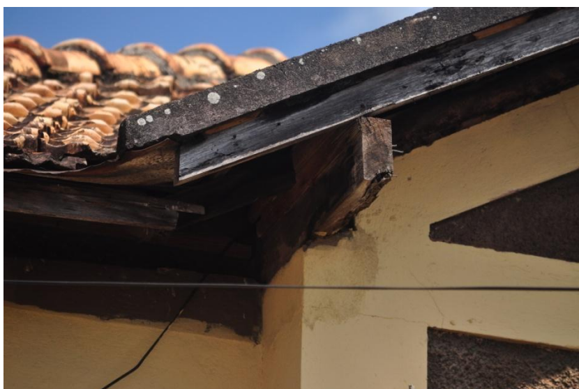
IGURA 34 - Pormenor de um dos beirais da cobertura.
