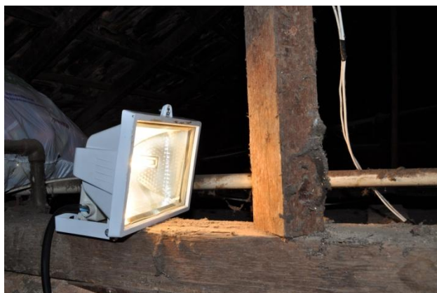
FIGURA 41: Fonte de calor aquecendo ligação.
