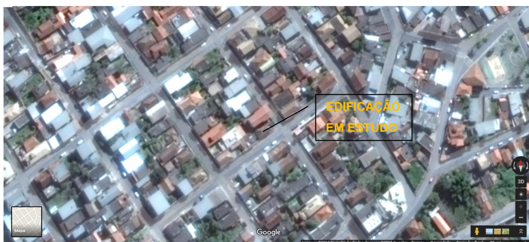
FIGURA 35 - Vista aérea da edificação.
