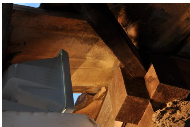
FIGURA 42: Fonte de calor aquecendo ligação.
