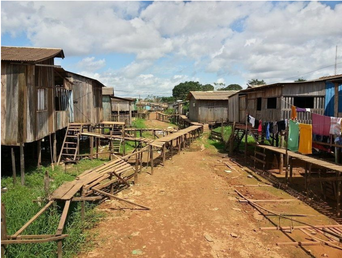
Figura 16 – Casas em palafitas no assentamento da “Invasão dos Padres”
