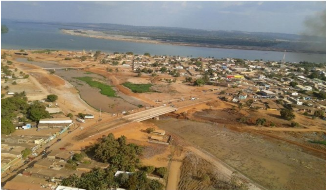
Figura 20 – Intervenções requalificadoras nas margens do Igarapé Altamira
