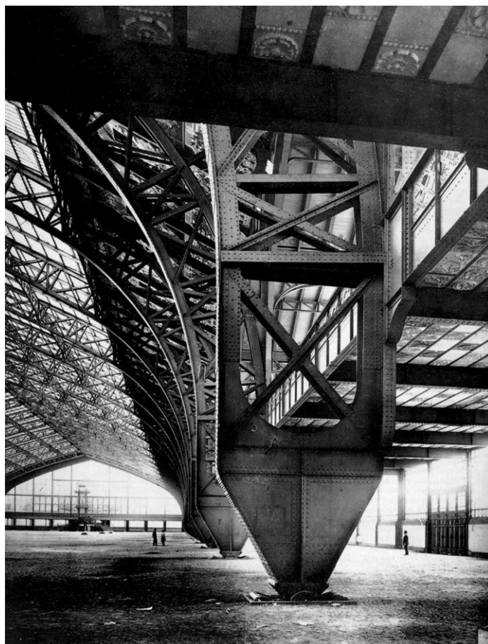
Base de um arco da Galerie des Machines . Studio Chevojon, 1889.
