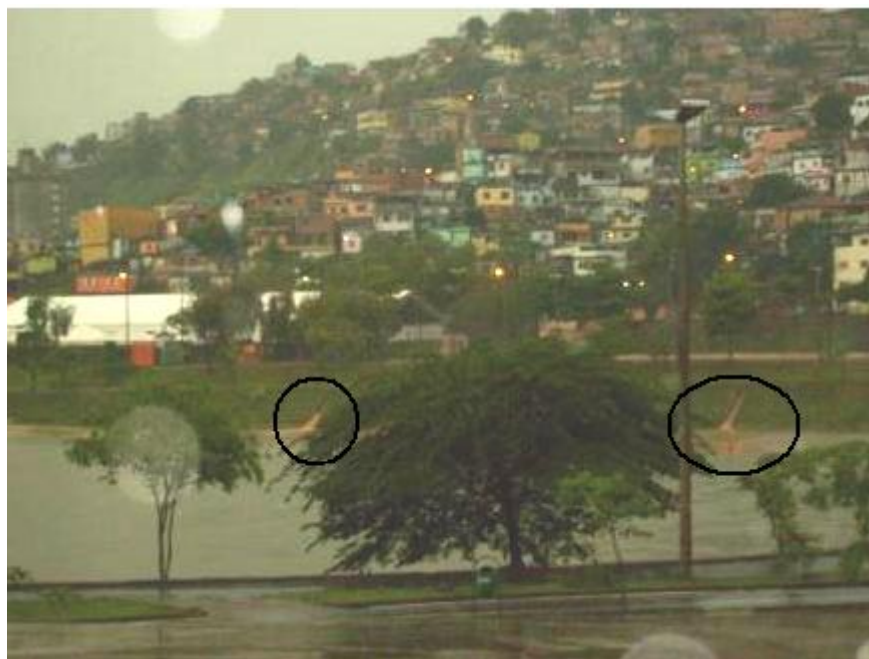
Figura 38: Escoamento superficial vindo da vila Barragem Santa Lúcia (ponto 1) sendo retido pela barragem. (Foto – Patrícia E. Reis, Outubro de 2010)
