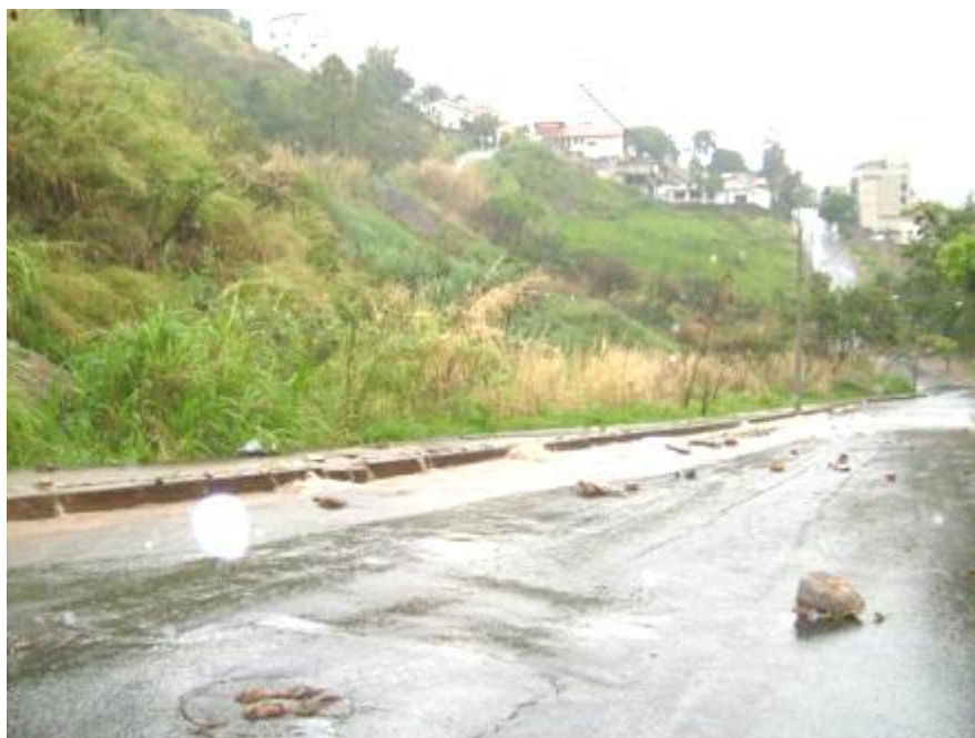
Figura 39: Fragmentos rochosos e pedregulhos espalhados por enxurrada forte ao longo da rua La Place, esquina com rua Zodíaco (ponto 3), após chuva intensa. As manchas na foto são gotas de chuva na lente da câmara. (Foto de Outubro de 2010).
