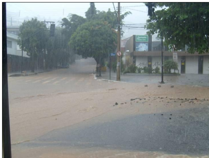
Figura 10: Carreamento de material pela enxurrada – Janeiro de 2009 – Bairro Anchieta, Belo Horizonte.
