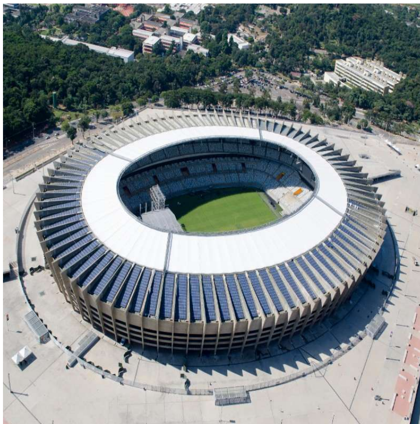
Figura 4 – Usina Solar Fotovoltaica Mineirão
